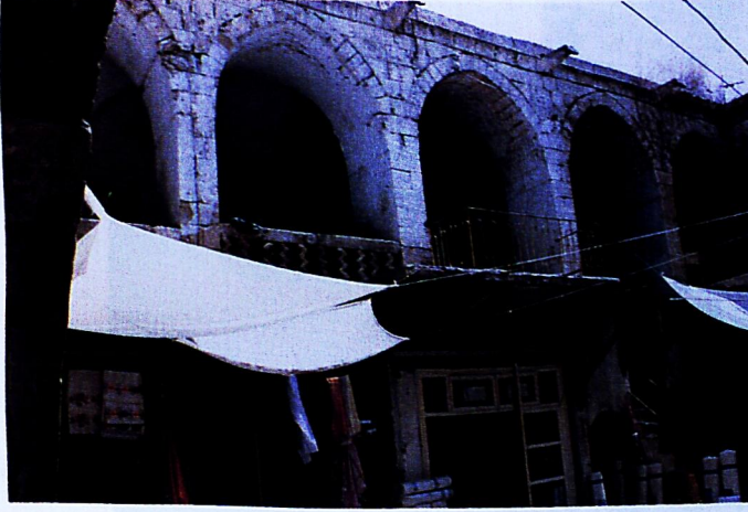
Resim 37: Hacı Kamil Hanı avlu kuzey kanatı.
