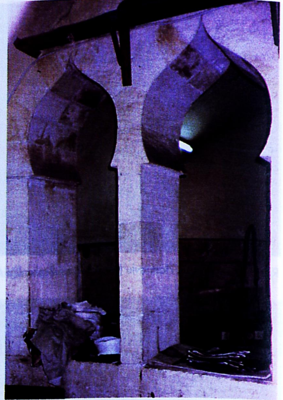
Resim 14: Gümrük Hanı birinci kat mekanlarını bölen pencereler.
