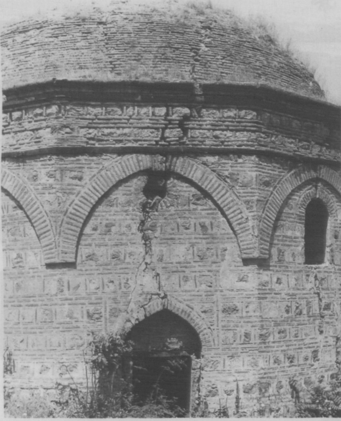
FOTO 5. GÜNEY-BATI CEPHESİ (D-E-F) (1976) KAYNAK; İHALE DOSYASI.
