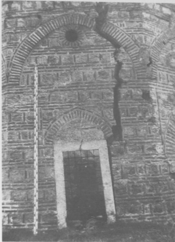
FOTO 22. KUZEY CEPHESİ ( M-A ) ( 1997 ).
