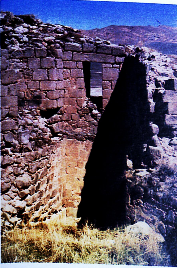
Resim 24: Pertek Kalesi kuzeydoğu burç iç görünüm.
