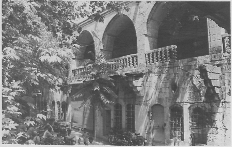
Resim 11: Gümrük Hanı zemin kat avlu kuzey kanadı.
