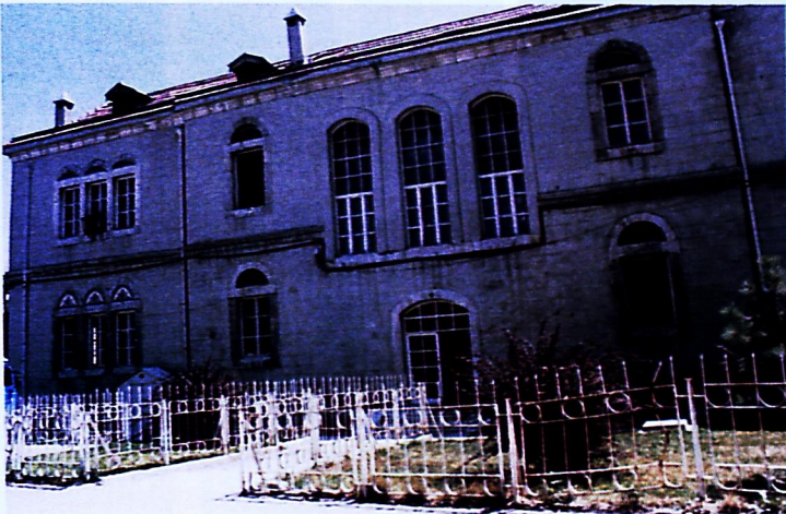
Foto 6: Konya, Sanayi Mektebi'nin kuzeye bakan arka cephesinden genel görünüş.(1996)
