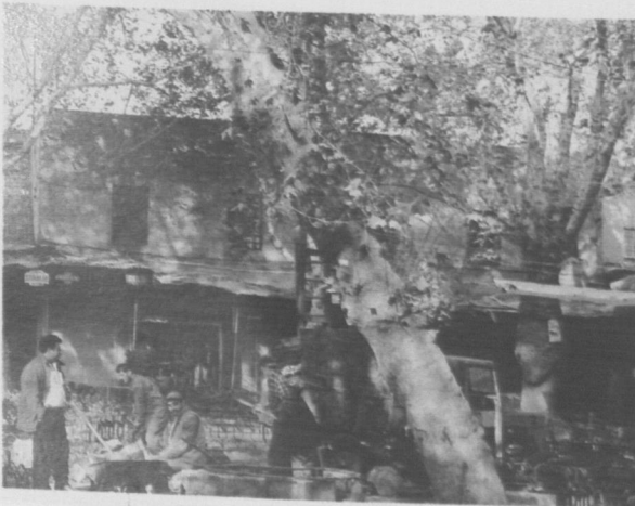
Resim 27: Mençek Hanı doğu cephe.
