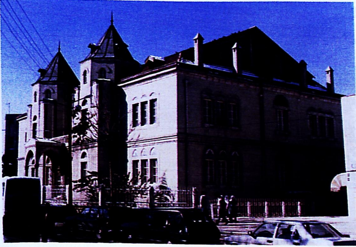
Foto 4: Konya, Sanayi Mektebi'nin güneye bakan ön cephesi ve doğuya bakan yan cephesinden genel görünüş.(1996)
