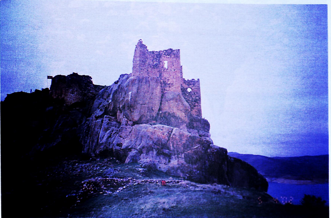
Resim 21: Pertek Kalesi kuzeybatıdaki burç.
