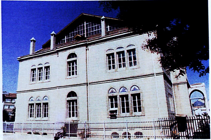
Foto 5: Konya, Sanayi Mektebi'nin batıya bakan yan cephesinden genel görünüş.(1996)
