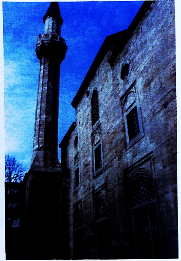
Câmînin yan cephesi.
