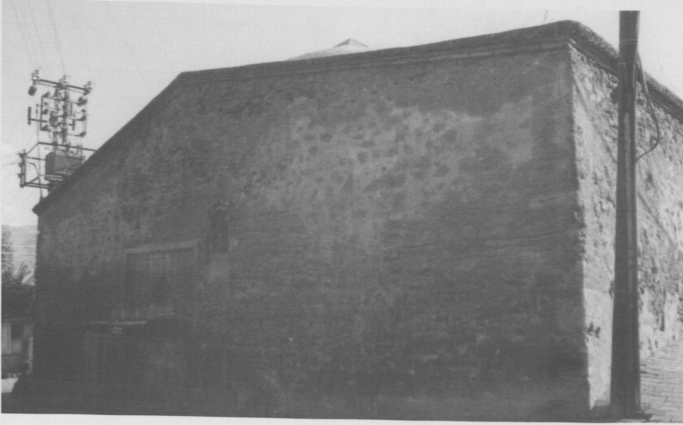
Res. 10: Tokat, Yörgüç Paşa Hamamı.
