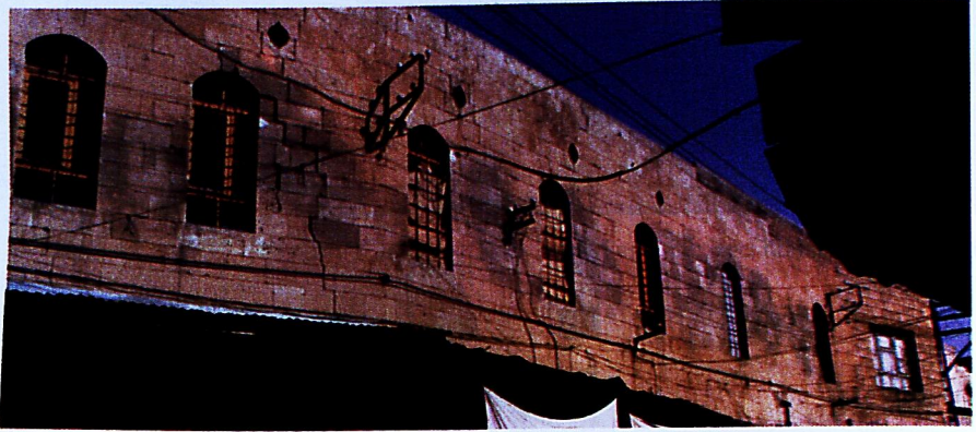
Resim 44: Şark İşhanı batı cephe.
