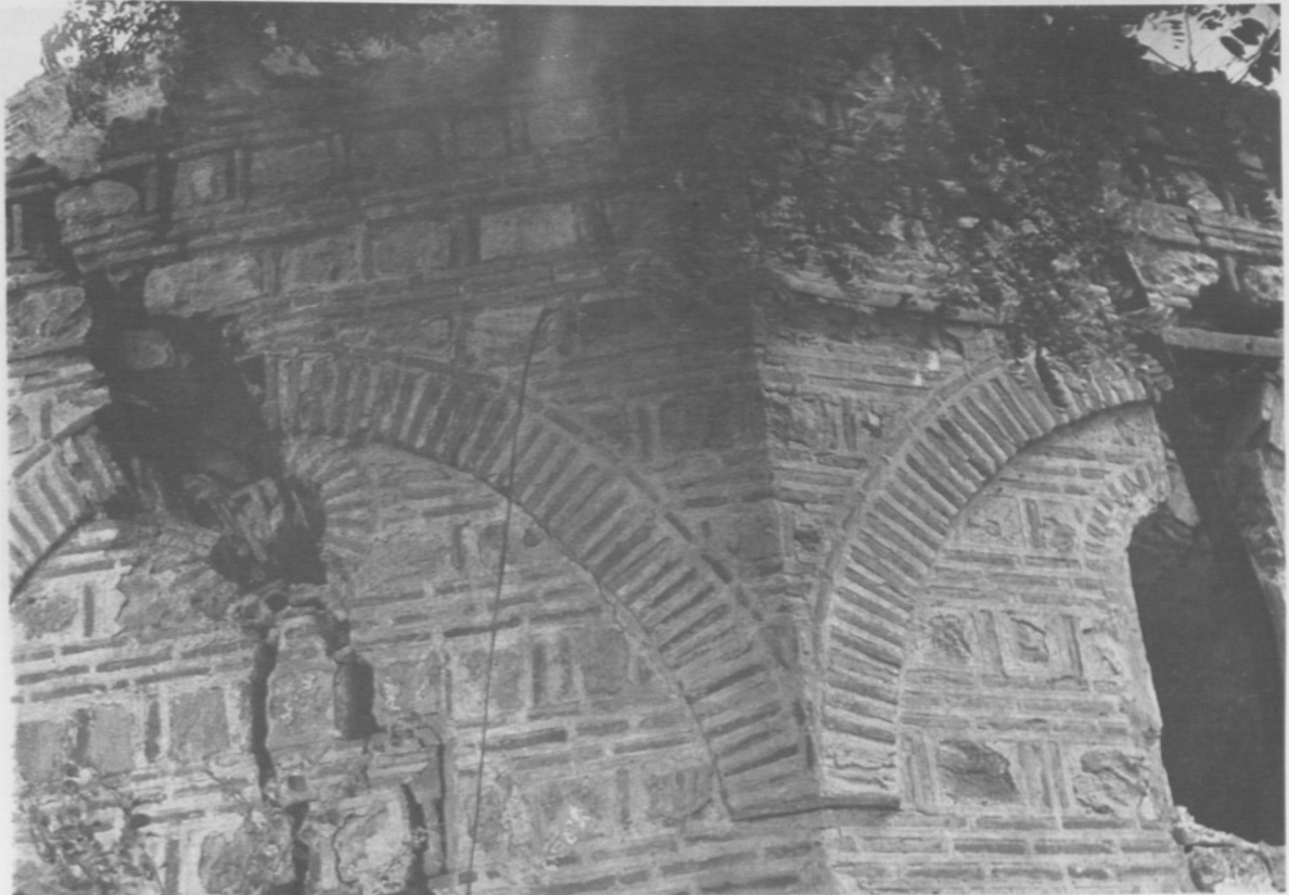
FOTO 30. DOĞU CEPHESİ ( H-J ) ( 1976, V.G.M.).
