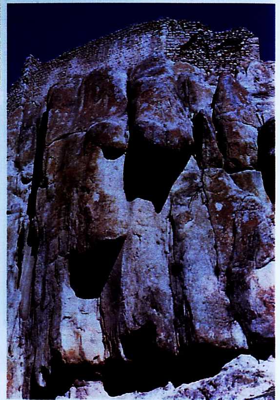
Resim 18: Pertek Kalesi güneydoğu köşe.
