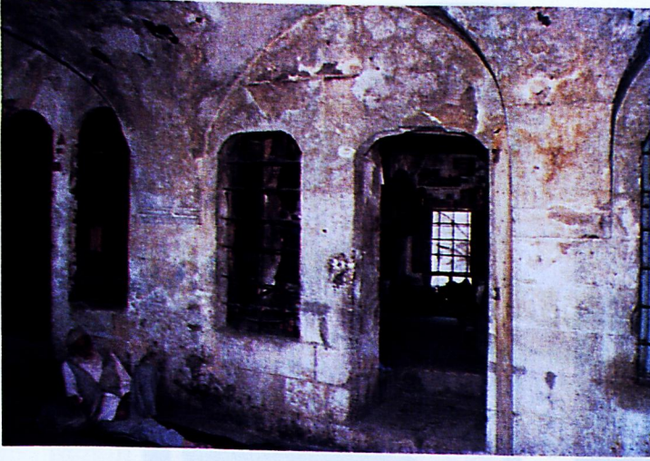
Resim 40: Hacı Kamil Hanı birinci kat mekan kapı ve penceresi.
