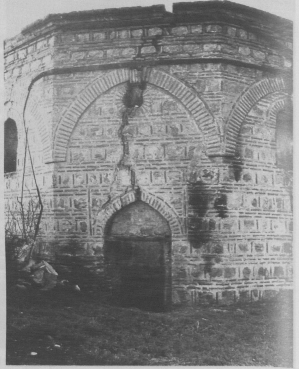
FOTO 25. DOĞU CEPHESİ ( H-J ) ( 1992 ).
