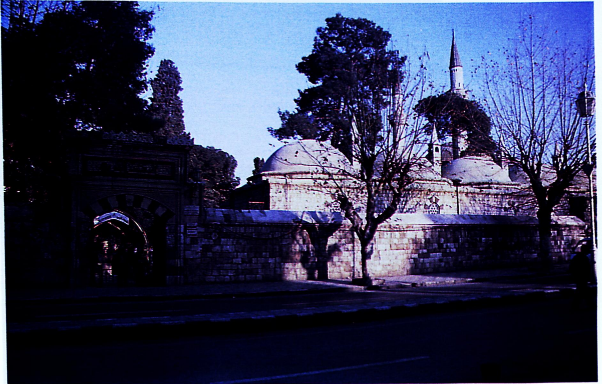
Lev. 22: ŞAM, Süleymaniye Külliyesi, Kuzey cephe avlu girişi ve imaret (Müderrişođlu, 2003).
