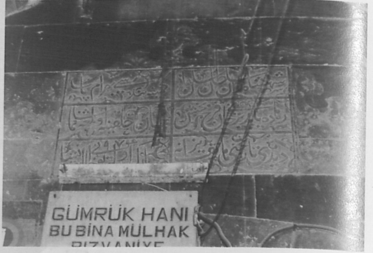
Resim 8: Gümrük Hanı giriş açıklığı üzerindeki inşa kitabesi.
