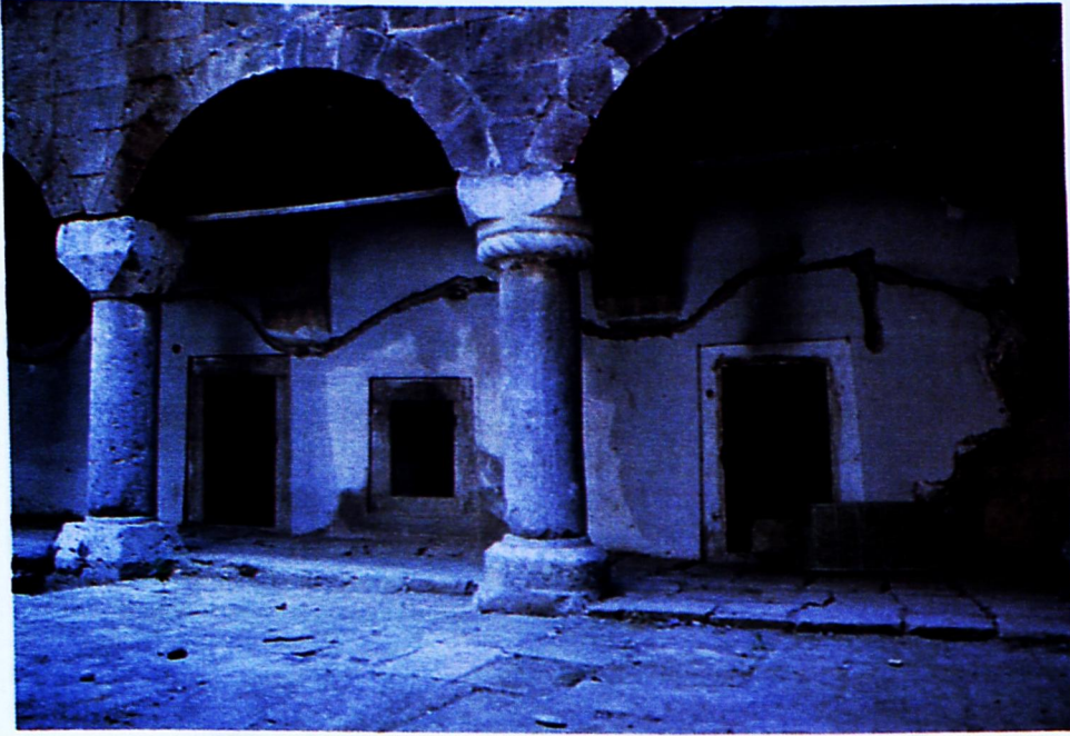
Fotoğraf 5: Hakkâri Meydan Medresesi Zemin Kat Revak Görünüşü.
