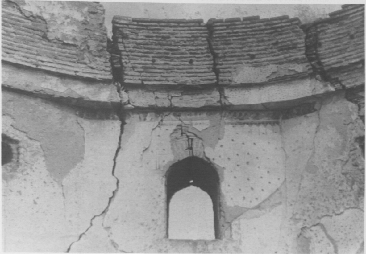
FOTO 35. İÇ GÖRÜNÜM (KALEM İŞİNDEN AYRINTI) ( J-K ) ( 1997 ).
