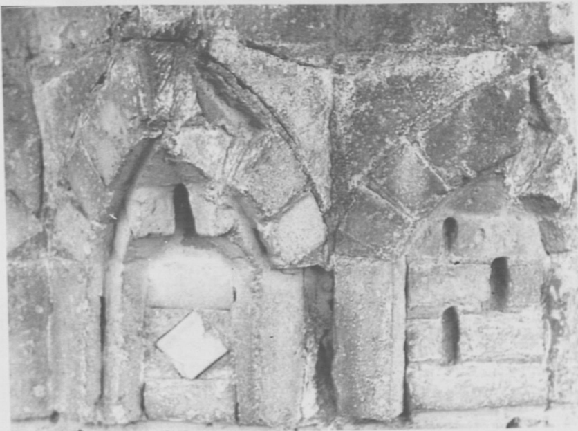
Fot. 17- Şerefe altı mukarnaslarından alt sıra ve bunların içine yerleştirilen turkuaz renkli kare ve dikdörtgen çiniler (1965).
