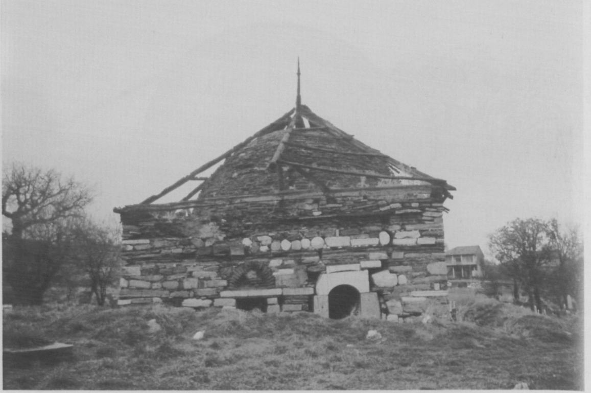
Fot. 3 Uşak ili, Karahallı ilçesi, Paşalar köyündeki Mahmud Paşa Türbesi.
