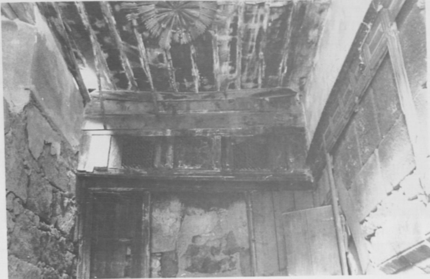
Fot. 51- Kayseri, Hoca Hasan İmaretinin giriş holünün üstünü örten tonoz yıkılmış olduğundan yerine muhdes ahşap tavan yapılmıştır (1976).
