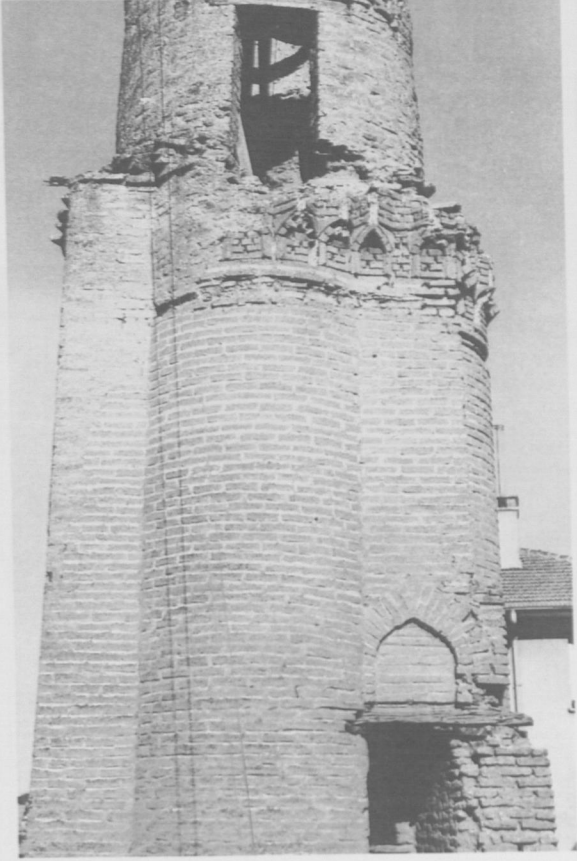
Fot.12- Minare batı cephe-petek, şerefe altı ve kubbeye çıkış kapısı (1963).
