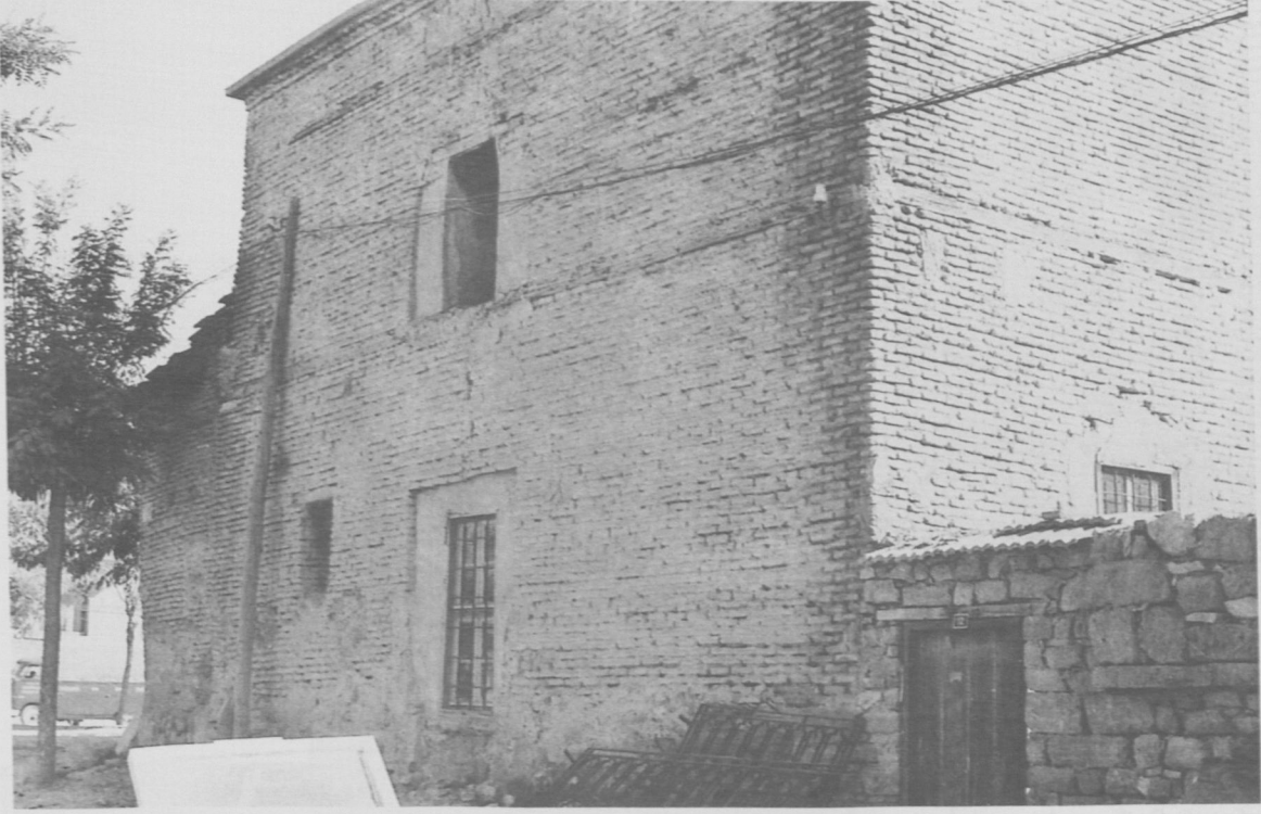
Fot. 3- Batı cephe (1963).
