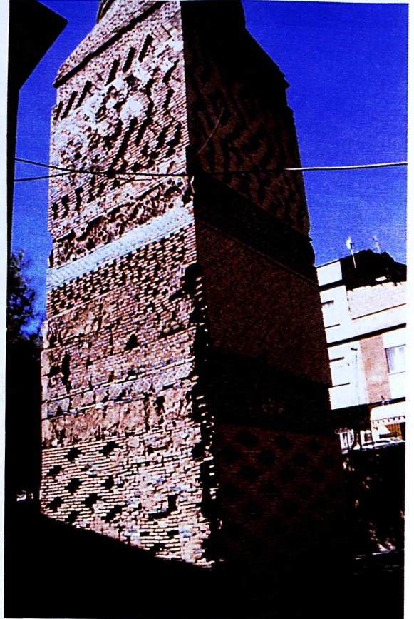
Fot.4 Siirt Ulu Cami Minaresi, Kaide Güneydoğu Cephe.
