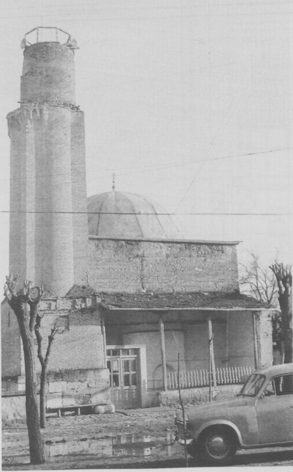
Fot. 1- Konya, Hoca Hasan Mescidi, kuzey cephe. (1963)
