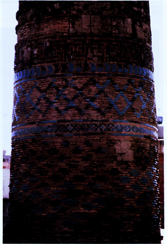
Fot.10 Siirt Ulu Cami Minaresi, Gövde Alt Bölümler, Kuzeydoğu Cephe.
