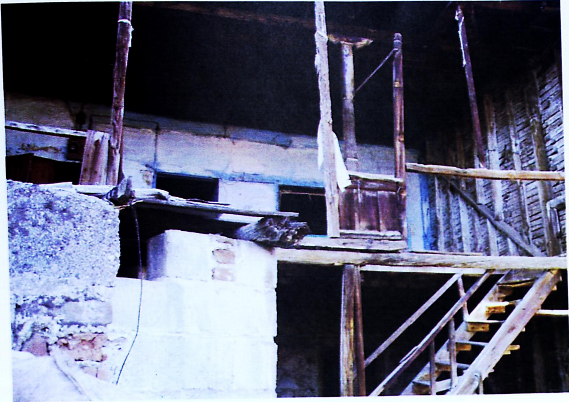
Fot.14: Buldan evlerinde merdiven.
