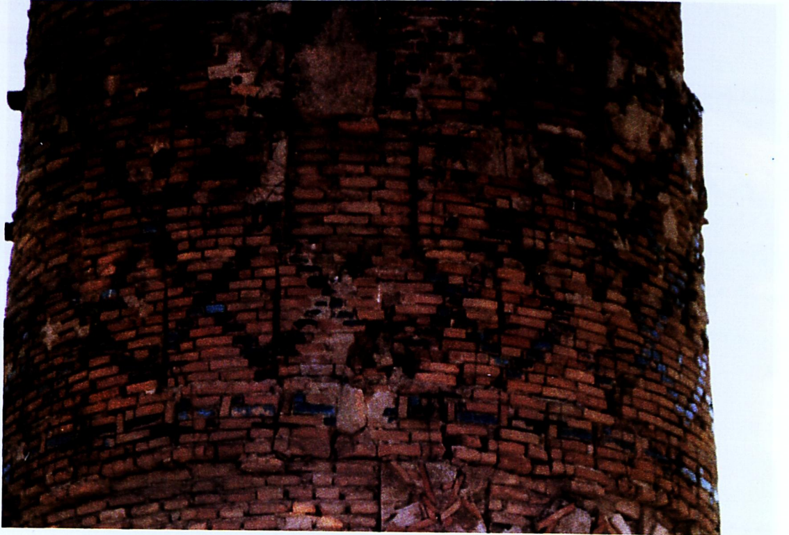
Fot. 12 Siirt Ulu Cami Minaresi, Gövde Üst Bölüm, Kuzeydoğu Cephe.
