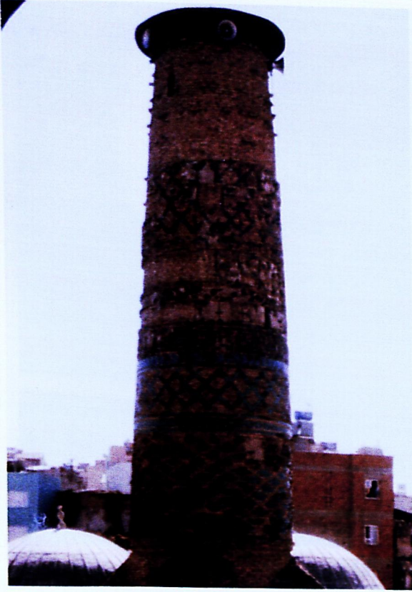
Fot. 9 Siirt Ulu Cami Minaresi, Gövde Kuzeydoğu Cephe.
