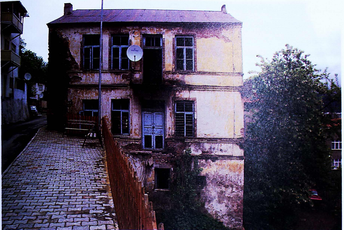
Fot. 14- Eski Askerlik Şubesi Binası, Artvin
