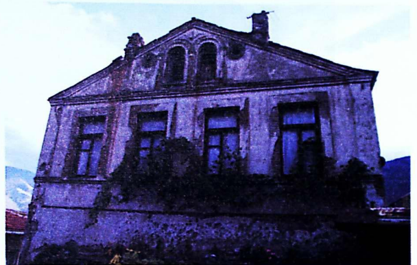
Fot. 40- Artvin evlerinde çatı alınlığı düzenlemeleri ve günümüze ulaşan bazı Antefiks ve Akroter örnekleri
