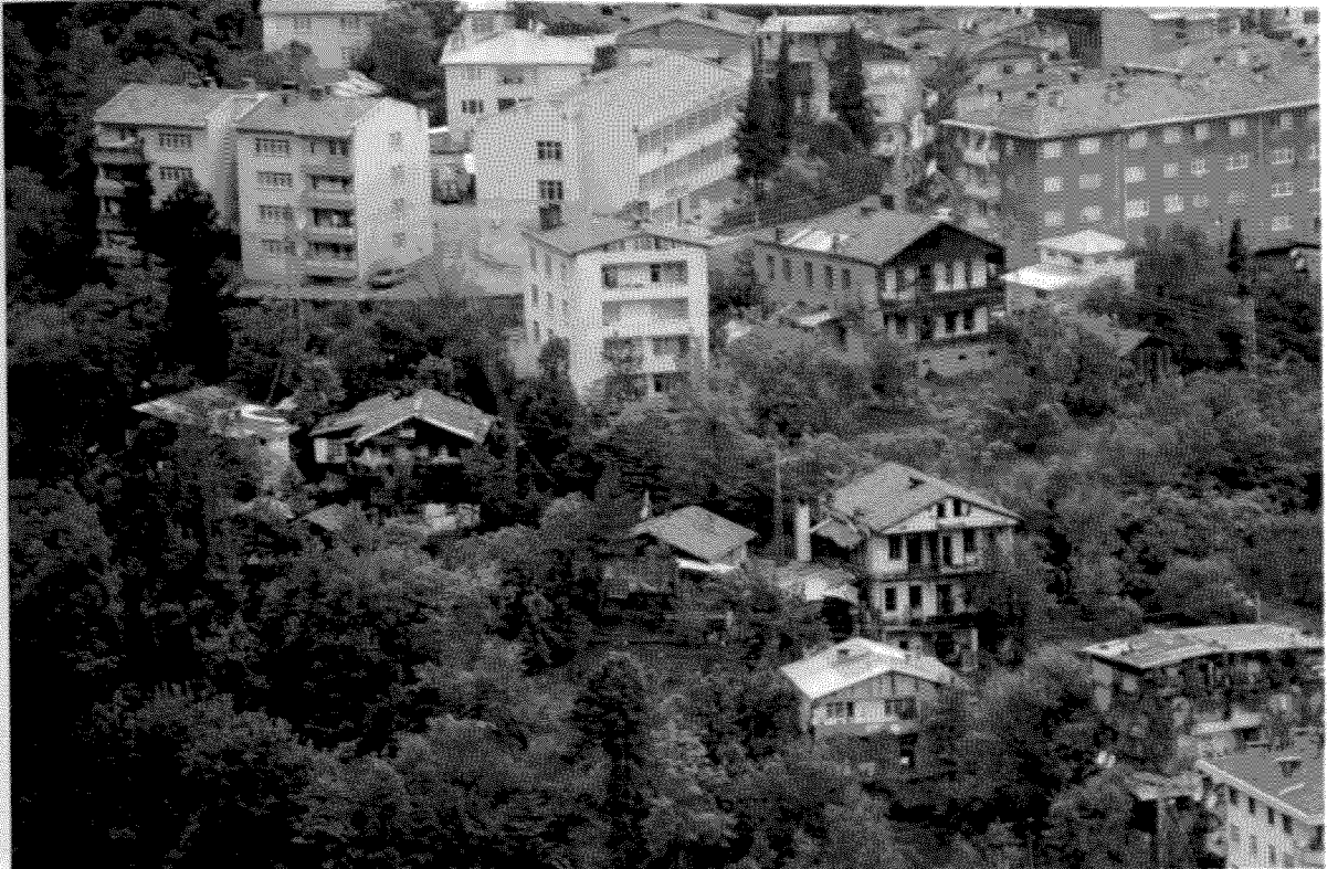
Fot. 2- Yıkılıp, 'yok olan' Artvin evleri
