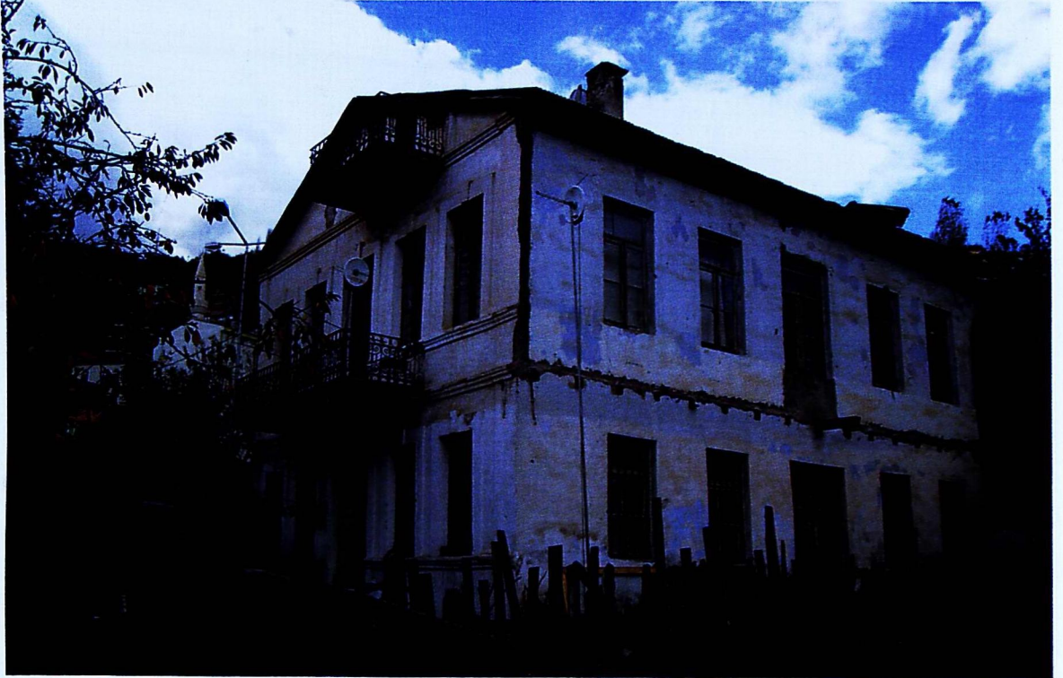
Fot. 28- Vahap İrmiş ve Ailesi Evi, Artvin
