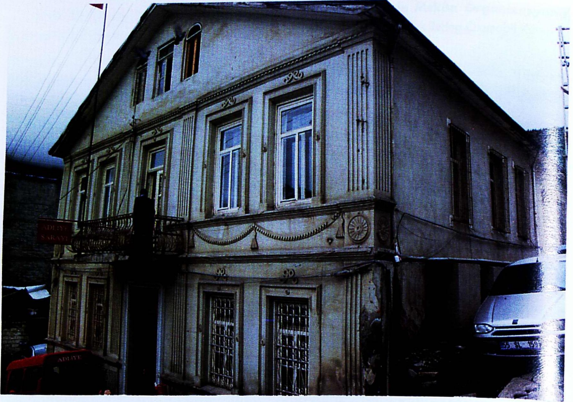
Fot. 3- Eski Adliye Hizmet Binası, Artvin
