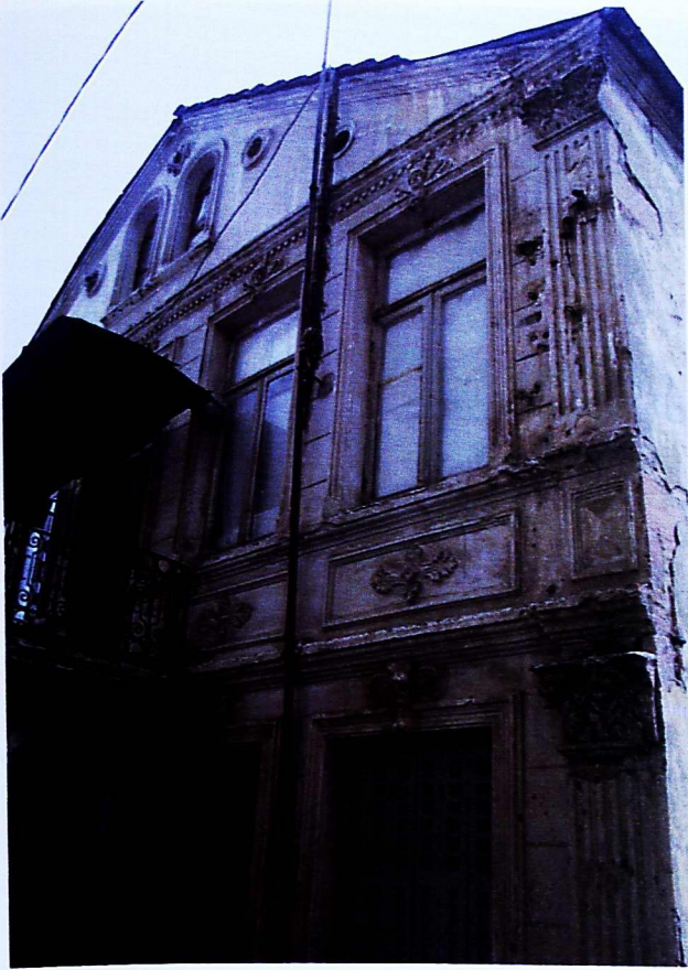
Fot. 5- Eski Tekel Binası. Tekel Sokak No 14
