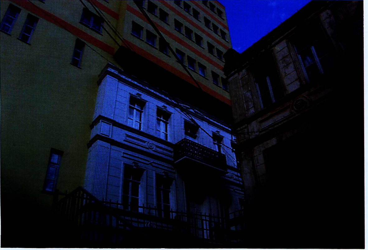
Fot. 37- İl sağlık müdürlüğü olarak kullanılarak yaşatılan tarihi bir Artvin yapısı ve yıkılarak Devlet Hastanesi strüktürü içinde sadece bir cephe imitasyonu ile yaşatılan bir başka tarihi Artvin yapısı ya da bir korumacılık ironisi!
