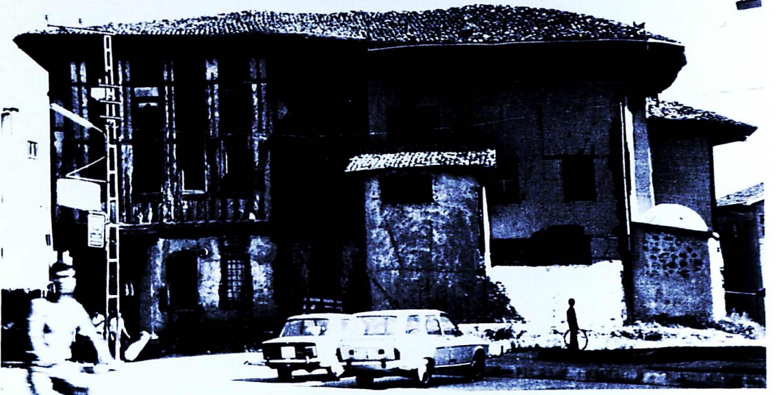
Fot.27- Tokat Latifoğlu Konağı. Onarım Öncesi Görünüm.
