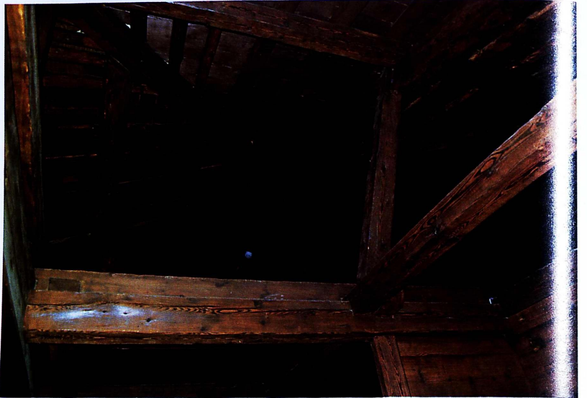
Fot. 8- Fuat Ersöz Evi Ahşap çatı konstrüksüyonu (Artvin Kültür Evi)
