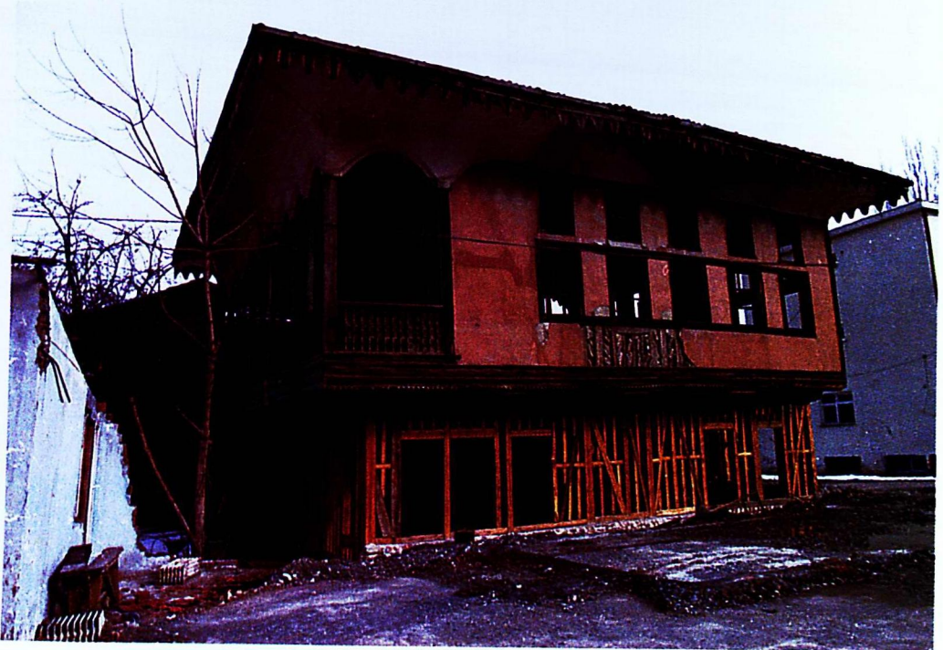
Fot.38- Tokat Mevlevihane Vakıf Müzesi. Onarım Öncesi.
