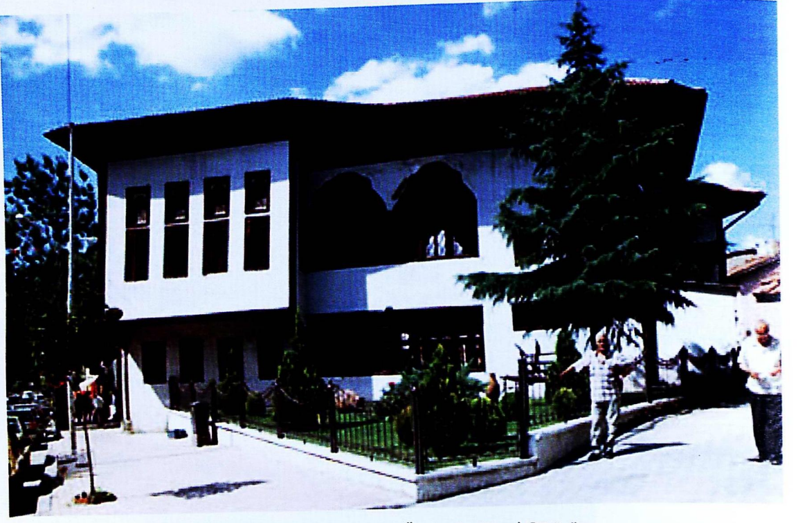
Fot.26- Tokat Latifoğlu Konağı. Ön Cephe Genel Görünüm.
