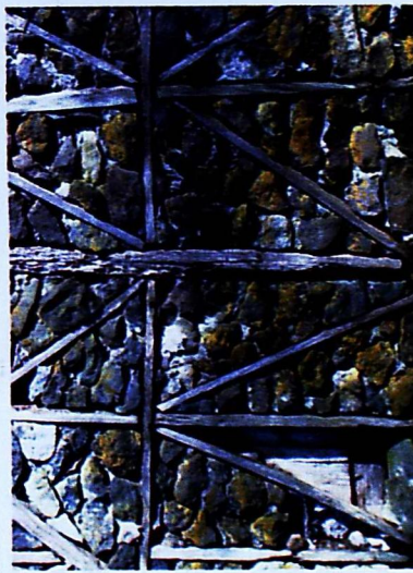
Fot. 32- Artvin Evlerinde uygulanan duvar tipleri
