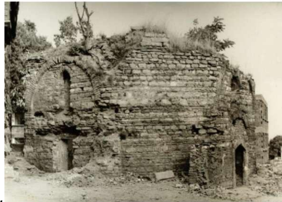
Resim 11. 1970'lerdeki onarım evveli ve sonrasına ait kuzeybatıdan çekilmiş fotoğraflar (Vİ.İ.B.M.A.)
