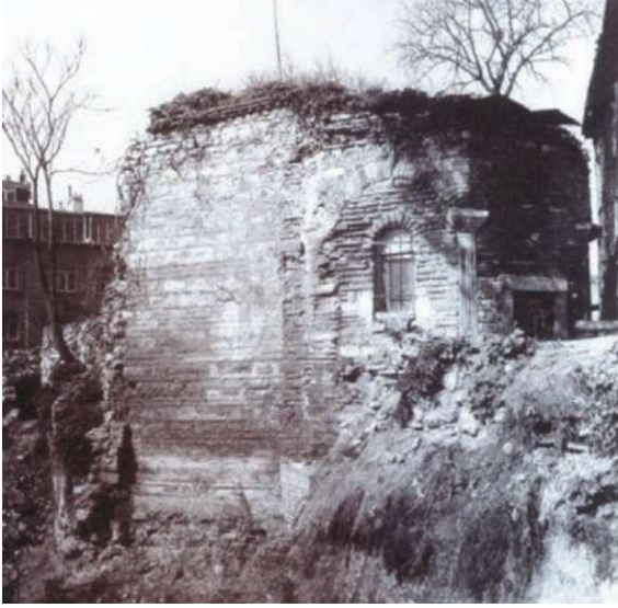
Resim,7.1970 öncesig.doğudanyapı (Wiener'den) Güneye doğru devam eden duvar izi
