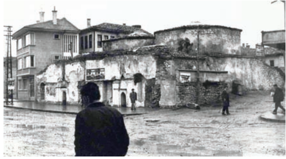
Fotoğraf 5: Tabaklar Hamamı'nın soyunmalık kısmı yandıktan sonraki durumu, güney ve doğu cepheler, İzzet Baysal Caddesi'nden görünüşü, 1964 (?) (VGM arşivi)
