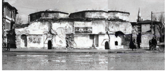
Fotoğraf 4: Tabaklar Hamamı'nın soyunmalık kısmı yandıktan sonraki durumu, güney cephe, İzzet Baysal Caddesi'nden görünüşü, 1964 (?) (VGM arşivi)
