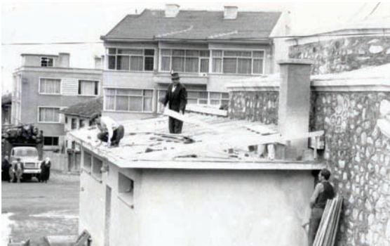
Fotoğraf 11: Tabaklar Hamamı'nın 1965 onarımı sırasında doğu cephedeki ilave (VGM arşivi)
