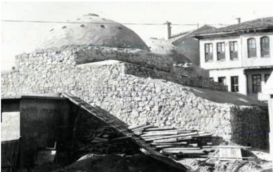
Fotoğraf 10: Tabaklar Hamamı'nın 1965 onarımı sırasında kuzey ve doğu cepheler (VGM arşivi)
