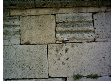
Şekil 6. Edirne Üç Şerefeli Cami Güney Cephesi/ taş blokları arasında içinde killi yumuşak tabakalar olan kötü kalitedeki tabakadan alınmış taşların yapılar da kullanılması görsel ve statik olarak kullanılması uygun değildir. Kayaç; gri, bej, beyazımsı renkli, kalker kayacı (dolomit%2, feldispat%0, kalsit%95, kuvars%0.2) (Dal, 2005).
