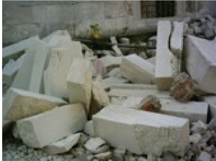
Şekil 10. Edirne Saatli Medresesinin restorasyonu için Urfa'dan getirilen taşların Edirne'nin hava koşullarında dona maruz kalmasıyla oluşan kalcal çatlaklar, büyük parça kopmaları şeklinde görülen tahribatları oluşmuştur.
