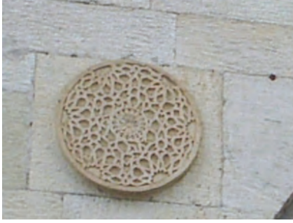
a-Giriş kapısı sol köşe (kuzeybatı cephesi)
