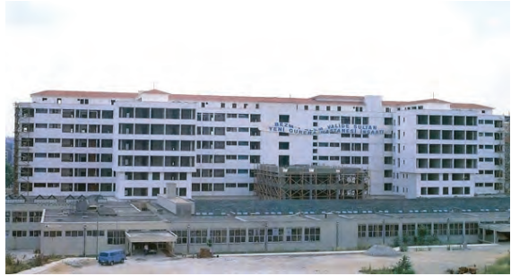
Resim 6. Yeni hastane binasının inşaatı
