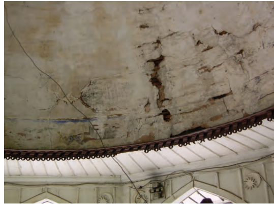
Resim 23- Restorasyon öncesi tren ve kale tasviri ile mukavemetini kaybetmiş sıvalı alanlar
