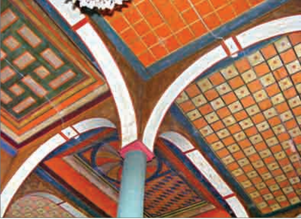
Resim 10: Sütunlar Arasındaki Bursa Kemerleri ve Tavan Süslemeleri.
