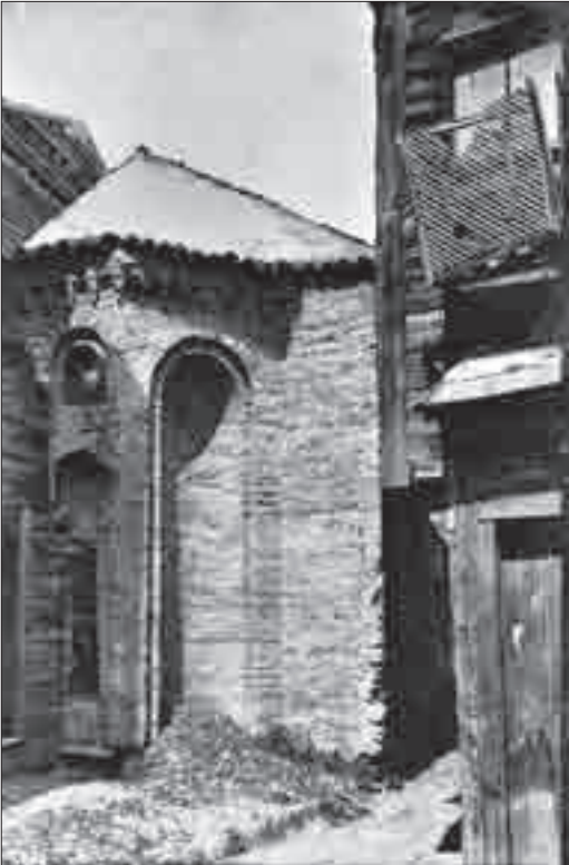
Resim 5. Yıkılmadan evvel mescidin apsis duvarı ve yol cephesi
