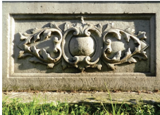
Resim. 11 Samsun Sultan Abdülaziz (Aziziye) Namazgâhi İnşa Kitabesi Ön Cephe Alt Pano.
