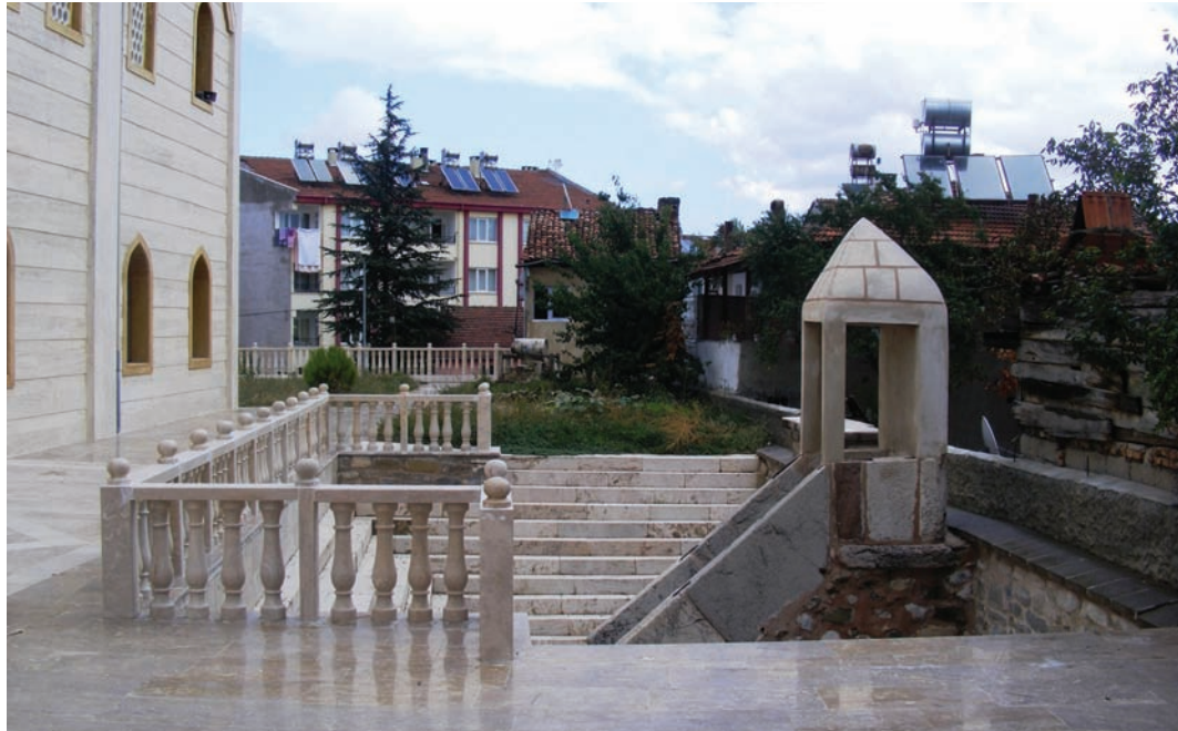
Resim 1 Veziroköprü Köprülü Mehmed Paşa Namazgâhı Batıdan Genel Görünüşü. (2008 Restorasyon Sonrası).
