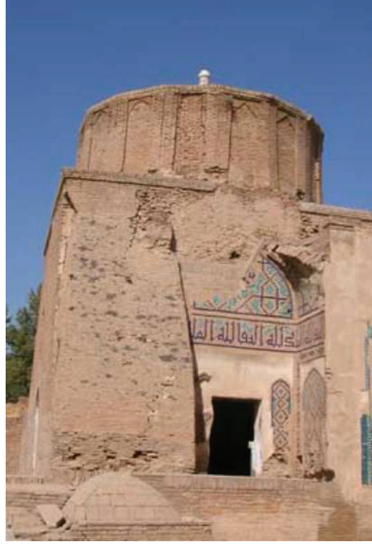
28. Emir Burunduk Türbesi portalı
