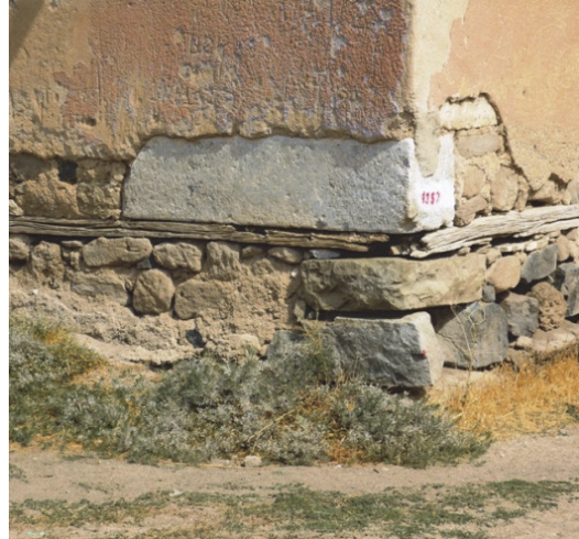
Fot.10. Değirmenyolu/Parlasan Köyü Hacı Ahmet Camii duvar örgüsü devşirme malzeme.
