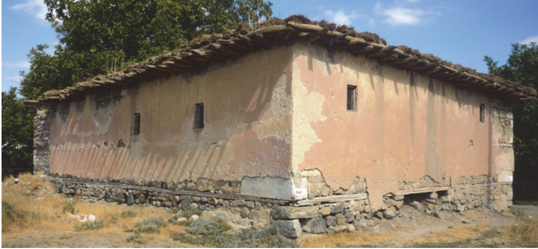
Fot. 6. Değirmenyolu/Parlasan Köyü Hacı Ahmet Cami'nin batı ve güneyden görünüşü.
