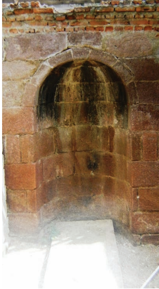
Resim. 8 Vezirköprü Köprülü Mehmed Paşa Namazgâhı Mihrabı. (2008 Restorasyon Öncesi - 2003).
