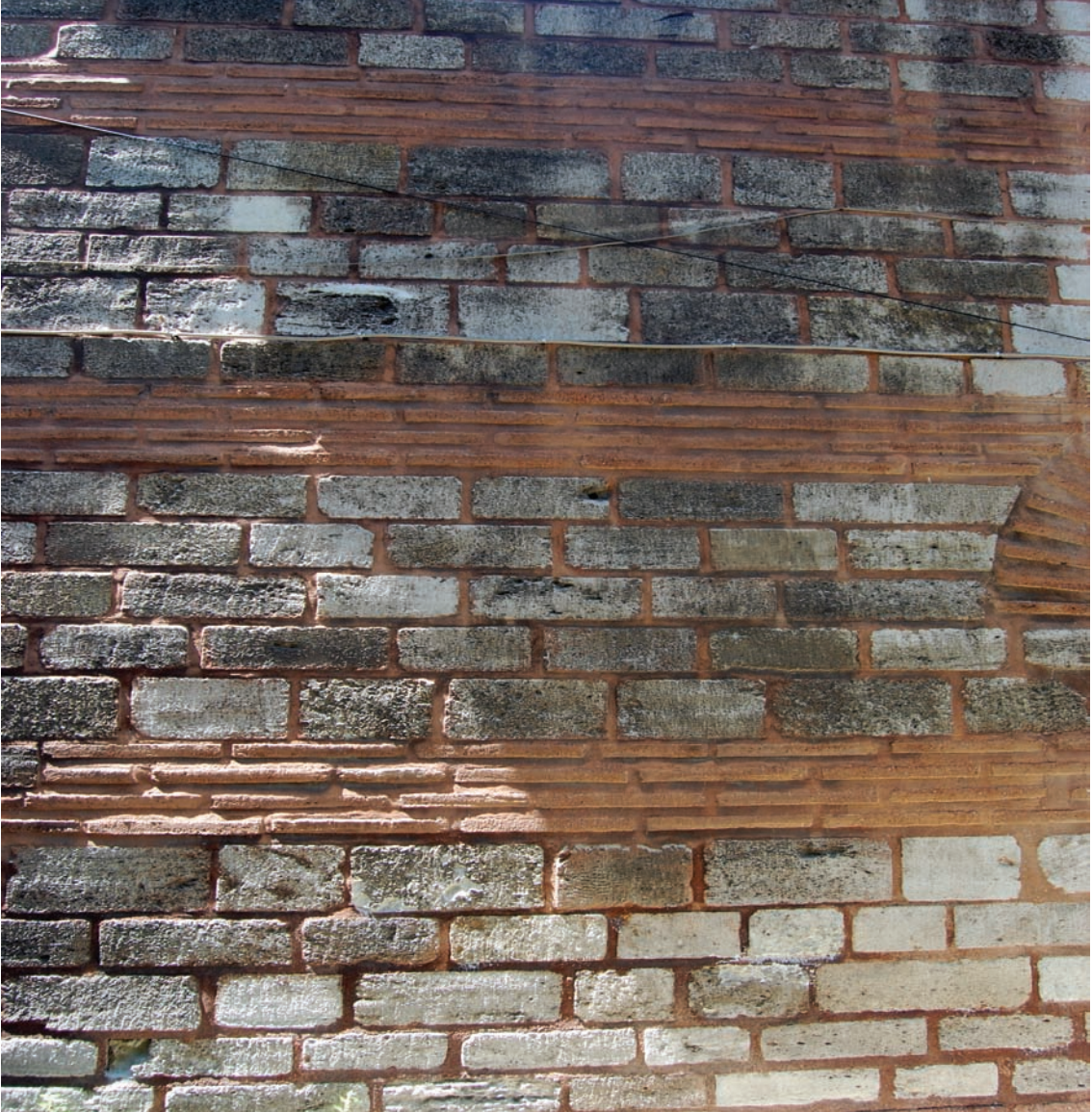
Resim 7. Mescidin almaşık duvar tekniği (M.Sav, 28.06.2012)
