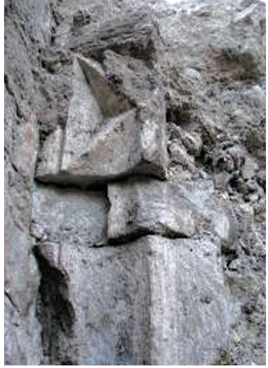
Resim-8: Güney cephesi süsleme detayı
