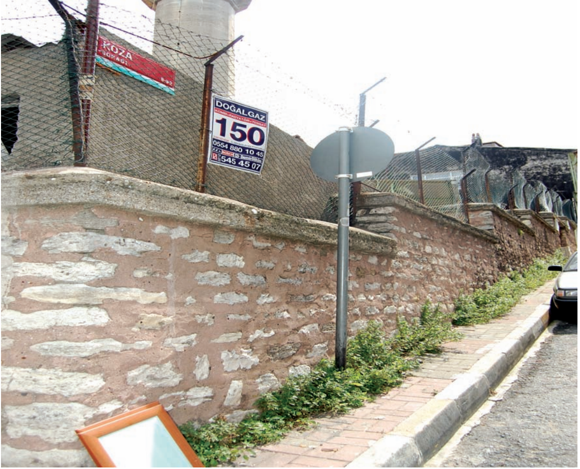
Resim 16. Mescidin Koza Sokağı boyunca uzanan betonarme harpuştalı, kademeli duvarı (M.Sav,26.06.2012)
