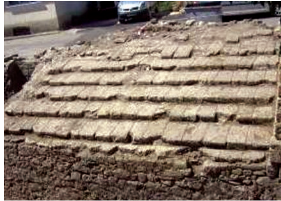
Resim-18: Çeşmenin plaka taşla kaplı üst örtüsü kazıdan sonraki görünümü (29.06.2012)
