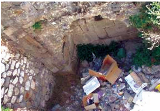
Resim-4: Kuzey cephesinin kazı ncesi grnm (26 Haziran 2012)
