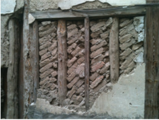
Resim 5. Alçının duvar kaplama malzemesi olarak kullanılması.
