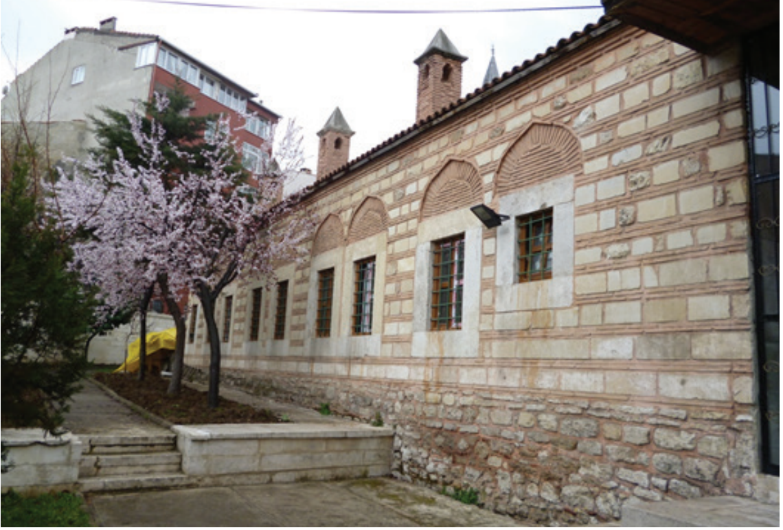
Resim 7: Mustafa Paşa Zâviyesi Güney Cephesi (2012)
