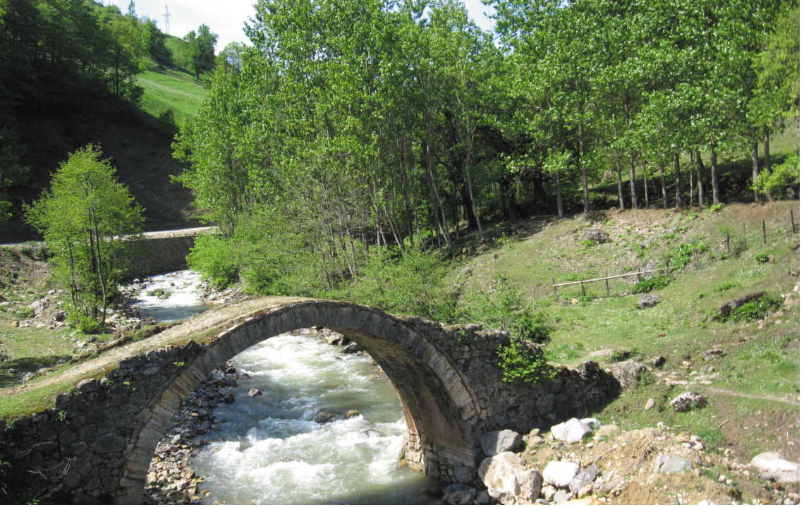
Resim-9: Şeyh Mustafa Köprüsü (Giresun/Dereli)
