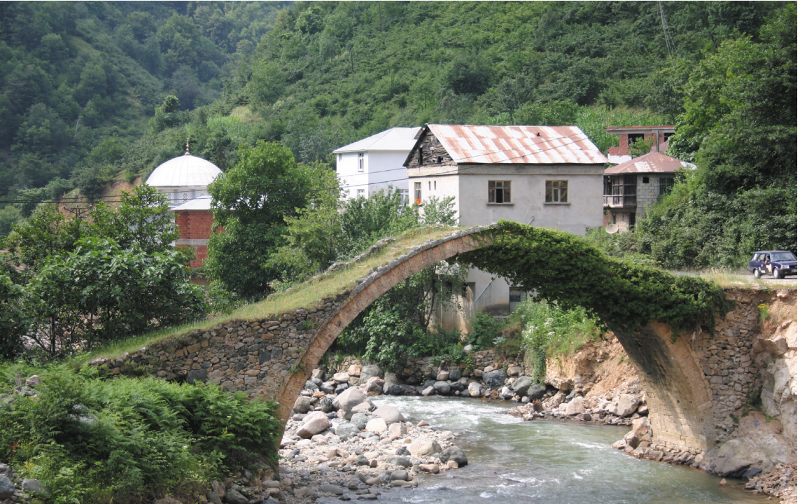
Resim-10: Kozbükü Köprüsü (Giresun/Yağlıdere)
