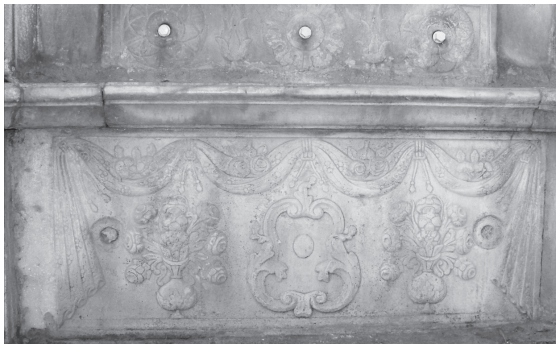
Resim 4: Karaosman Sebili Beden Duvarlarının Alt Panosu
