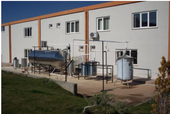
Şekil 1. Yekarum'daki 10 m 3 'lük termofilik ve mezofilik çalışabilen biyogaz ünitesi
