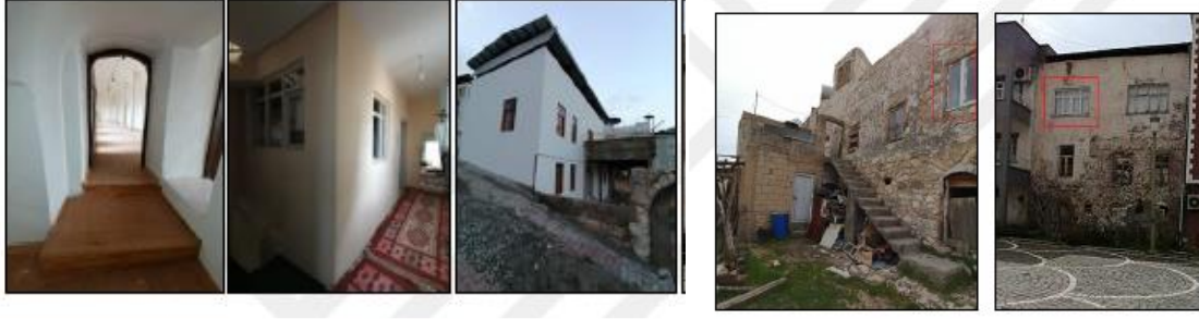
Şekil 19. Geleneksel Tillo evleri pencerelerinde PVC kullanımı ile iç ve dış duvarlarda suni boya kullanımı
