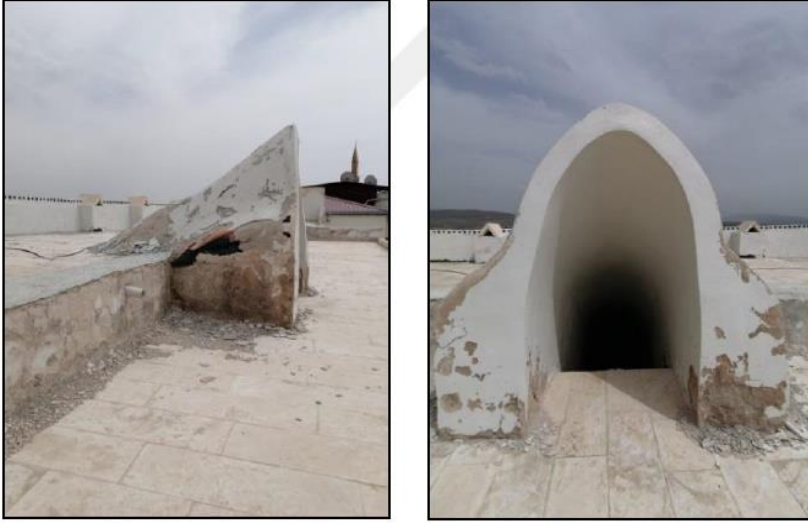
Şekil 8. Şeyh Nasrettin Evi'ne ait dam ile camelon örneği
