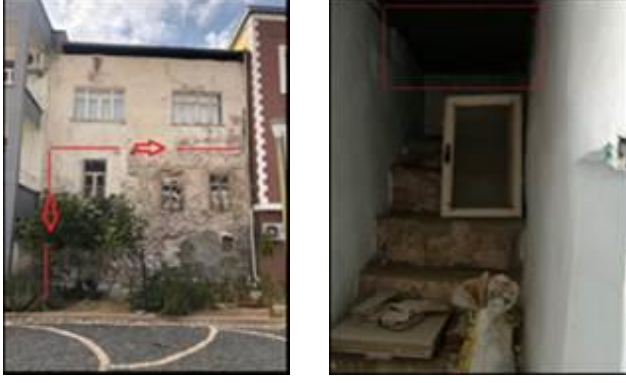
Şekil 17. Geleneksel Tillo evinde düşey ve yatay doğrultuda bölünmeler
