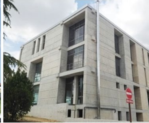
b. Güneybatı ve Güneydoğu Cephesi Detay
