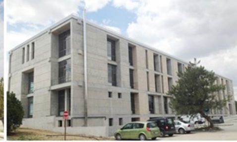
d. Güneybatı ve Güneydoğu cephesi
