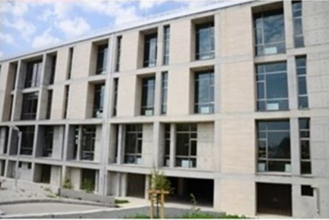
c. Güneydoğu Cephesinden Bir Bölüm
