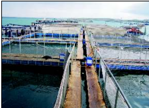
Şekil 1. Kafes ünitesindeki bir servis yolu.
