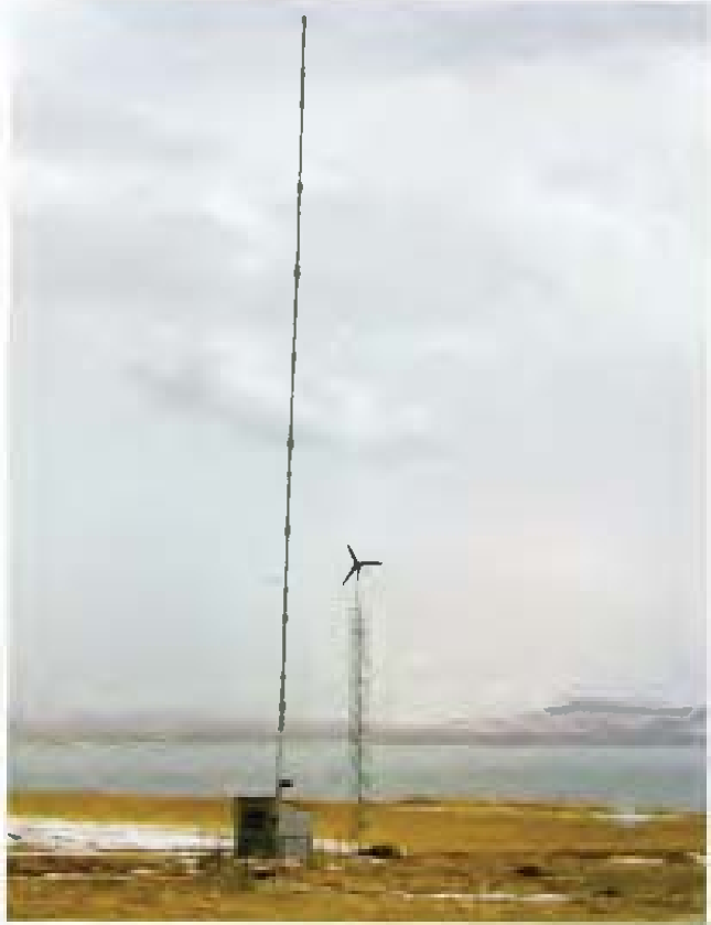
Şekil 1. Yüzüncü Yıl Üniversitesi kampüsüne kurulan rüzgar ölçüm istasyonu.
