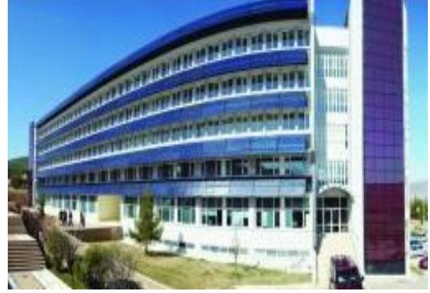
Şekil 14: Muğla Üniversitesi'nde güneş enerjisi uygulamasına örnek
