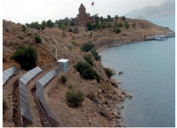
Şekil 6: Akdamar Adası güneş enerjisi uygulaması
