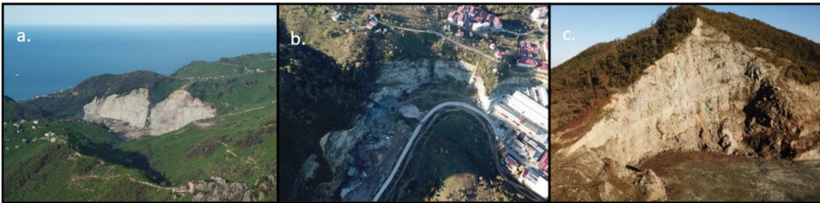
Fotoğraf 8: Dolgu malzemesi temini için açılan taş ocağı (a.) ve sanayi alanı ihtiyacını karşılamak için topografyanın kazılarak düzeltilmesi (b. ve c.)
