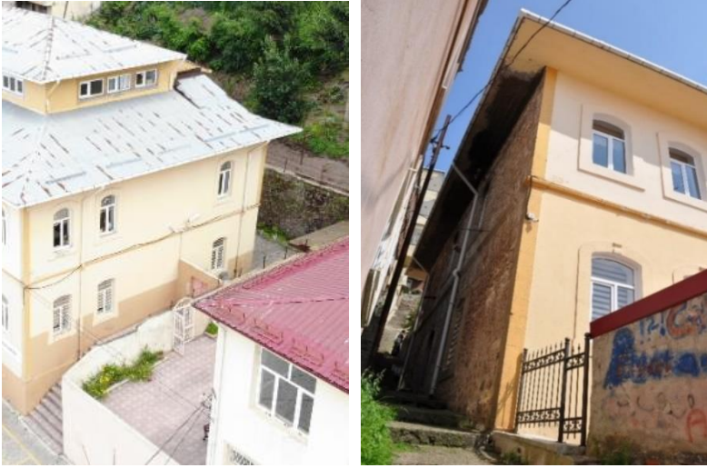
Görsel 7-8: Kazım Karabekir Ortaokulu Batı ve Doğu Cephesi Görünüşü
