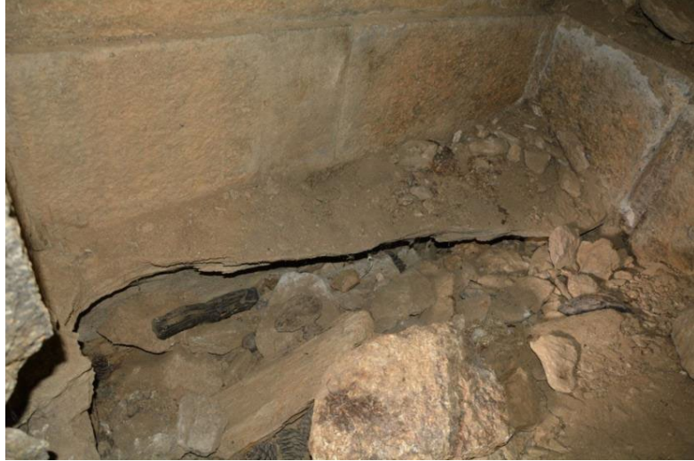
Figür 14. Batı Duvardaki ölü yatağı ve korkuluk geçme yerleri
