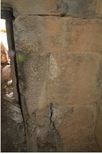
Figür 12. Çapraz kesim uygulanan dikine blok
