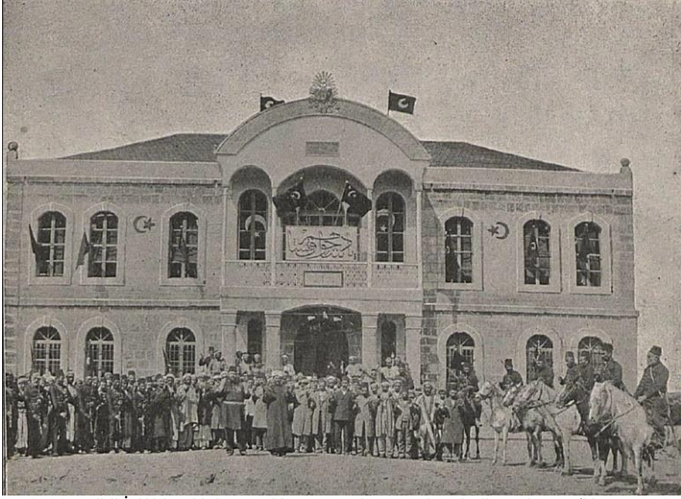
Foto 13. 1903 tarihli İslâhiye Hükümet Konağı açılış töreni ve balkon detayı (Umar, 2017, s.76)
