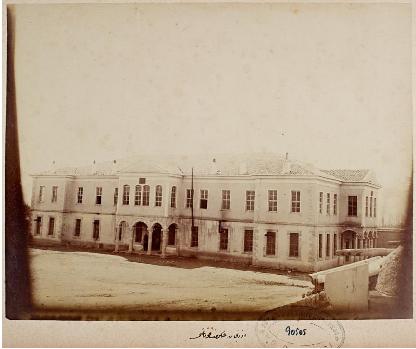
Foto 3. Erzincan Hükümet Konağı cephe merkezlerine yerleştirilen cumbalı çıkıntılar (İ.Ü. Nadir Eserler Kütüphanesi, 90505/0003)
