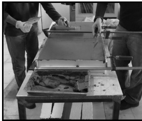
Şekil 4. Yalıtım levhalarına sıva yapılması
