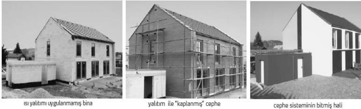
Őekil 1. Bina dış cephe yüzeyine ETICS uygulamaları
