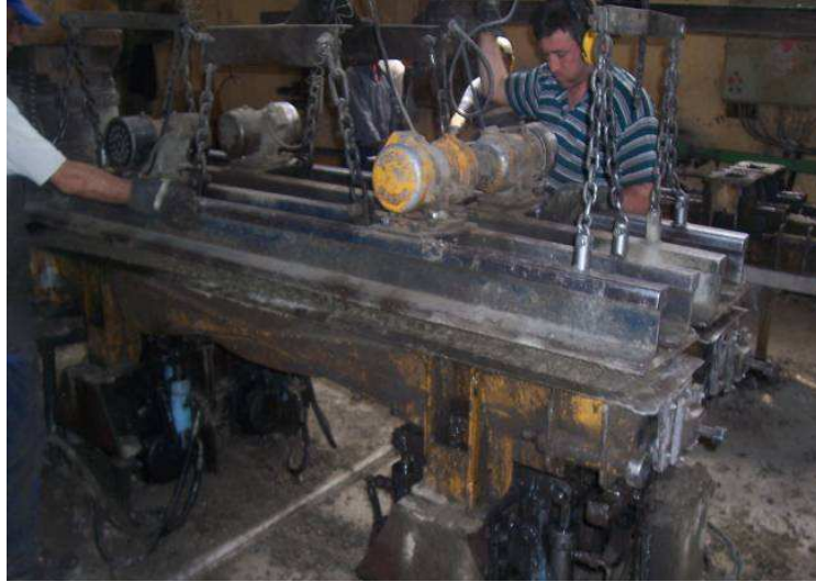
Őekil 2. Vibratörlerle donatılmış sıkıřtırma kiriři ile beton traversin sıkıřtırılması
