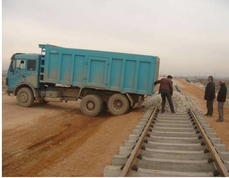
řekil 5. Üretilen beton traverslerin yol pozunda kullanılması
