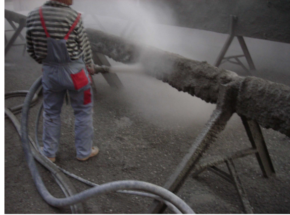
Şekil 1. Püskürtme Beton Uygulaması [4].
