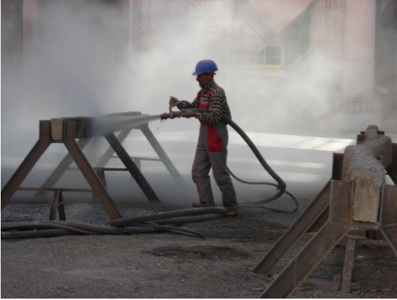
Şekil 1. Püskürtme Beton Uygulaması [4].
