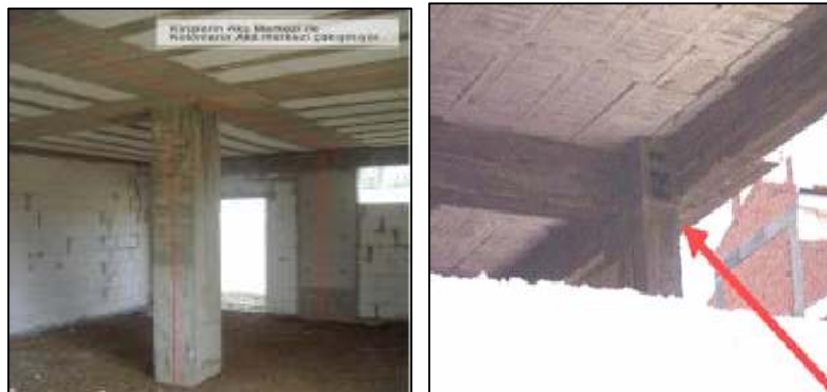
Şekil 20-21. Temelde kolon aplikasyonu hatasının statik sistem bozukluğuna yol açması
