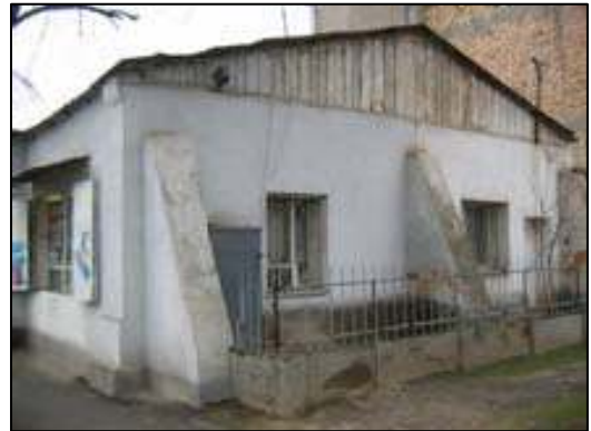
Şekil 7. Taşıyıcı Duvarların Desteklenmesi [3].
