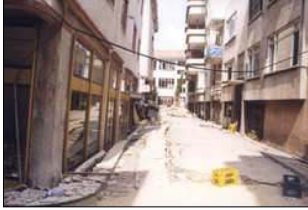
Şekil 25. Sıvılaşma potansiyeli yüksek olan zemine bina yapılması
