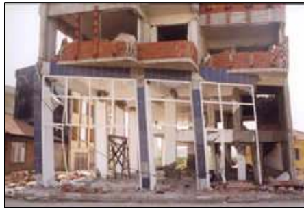
Şekil 14. Deprem Perdelerinin Simetrik Yerleştirilmemesi (17.08.1999 Adapazarı)
