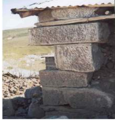
Şekil 5. Sağlam ve Tok Yapılı Köşe Bağlantılı Bina
