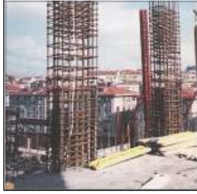
Şekil 18. Doğru Bir Etriye Sıklaştırma Uygulaması
