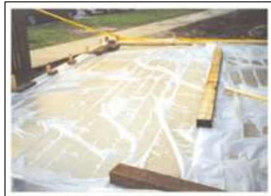
Şekil 14-15. Beton Karışım Suyunun Belli Bir Süre Beton Bünyesinde Kalması İçin Beton Sık Sık Sulanmalı
