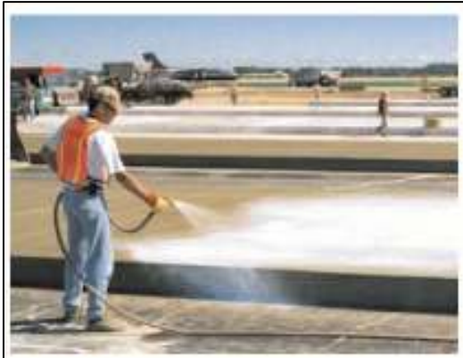
Şekil 14-15. Beton Karışım Suyunun Belli Bir Süre Beton Bünyesinde Kalması İçin Beton Sık Sık Sulanmalı
