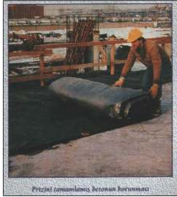
Şekil 16-17. Beton Yüzeyinin Kür Maddeleriyle Kaplanması
