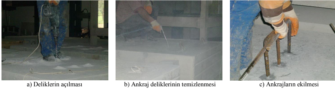
Şekil 2. Ankraj Ekim İşlemleri
