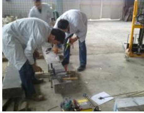
Şekil 5. Çelik plakaların epoksi yardımıyla kirişe yapıştırılması
