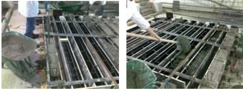
Şekil 2. Kiriş numunelerin beton döküm aşaması
