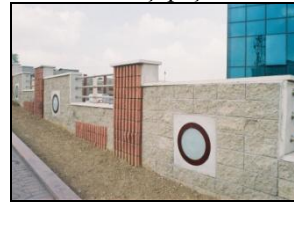
6. Traverten kaplama duvar kaplama
