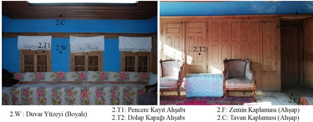
Şekil 5. Zabunlar Evi başodası iç mekân yüzeylerini oluşturan malzemelerin ışık yansıtma çarpanı ölçüm noktaları (Measurement points for the surface reflectance in the main room of Zabunlar House)
