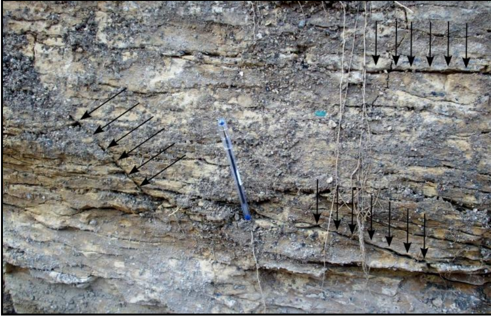
Şekil 3. Kaya kütlesinde gelişmiş eklem takımları
