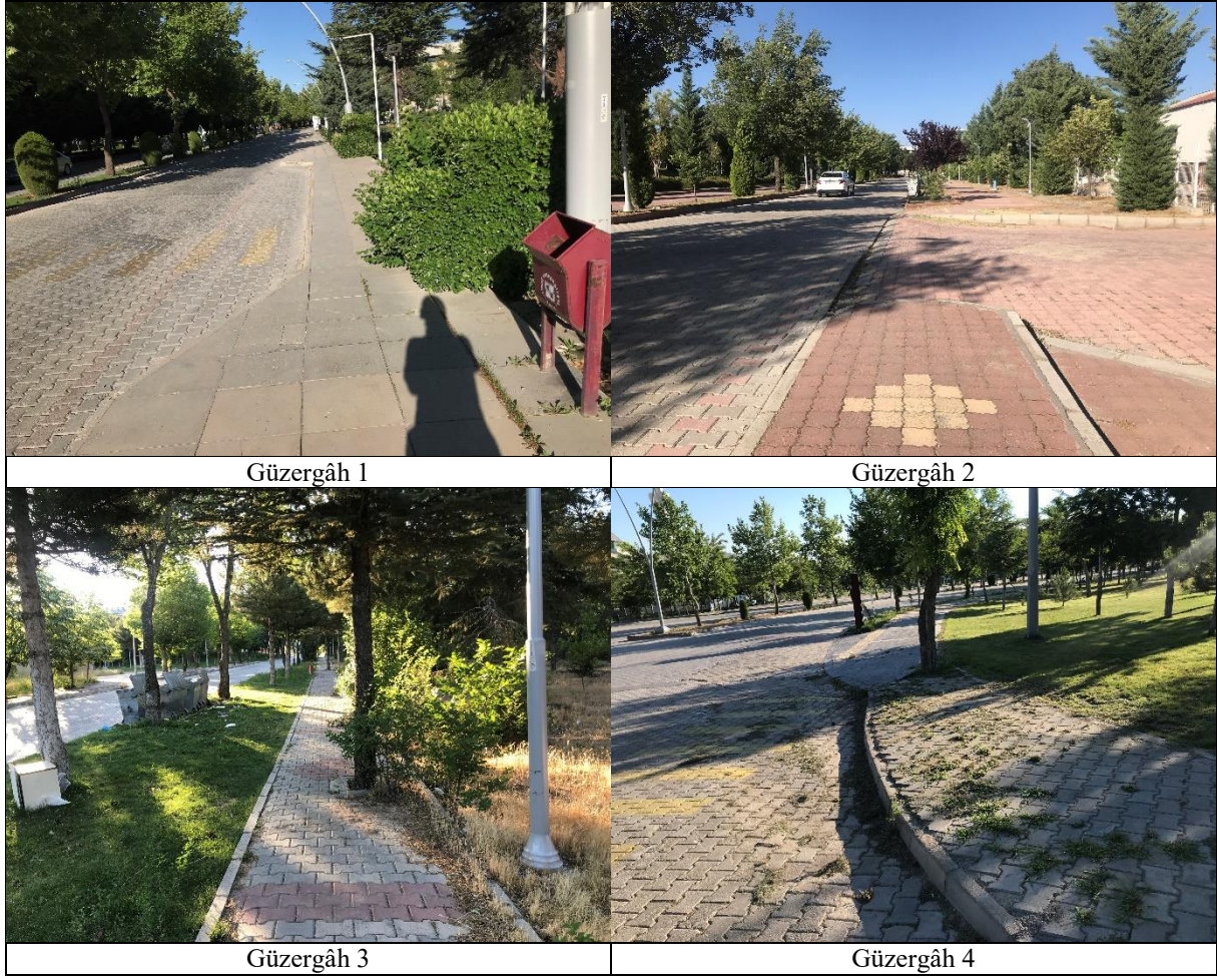
Şekil 9. Yerleşke ulaşım ağında kaldırım sürekliliği sorunu.
