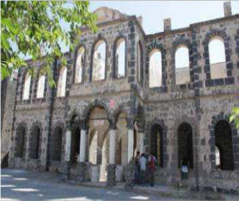
Şekil 6. Kolor- du Binası*
