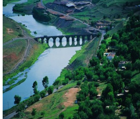
On gözlü Dicle Köprüsü
