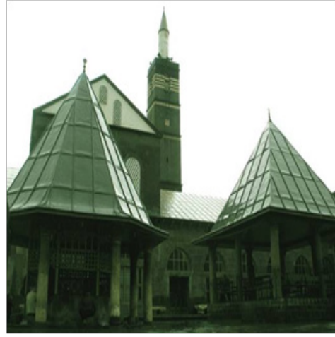
Diyarbakır Ulu Camii
