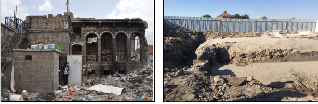
(a) (b) Görsel 3. Yapının 2016 yılında doğu ve kuzey kanadının yıkık durumu ile 2019 yılındaki tümüyle yıkılmış durumu (Vakıflar Bölge Müdürlüğü Arşivi).
