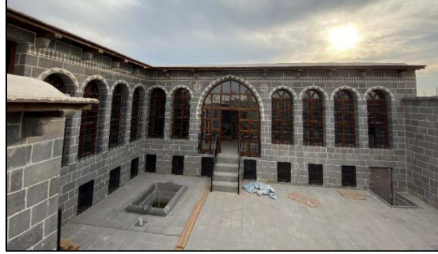
Görsel 11. Yeniden yapım süreci tamamlanan çorbahane güney kanadı (Işık, 2021).
