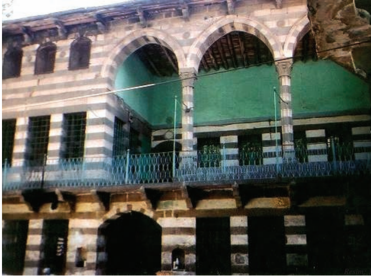
Resim: 1 Behram Paşa Konağı üç kemerli eyvanı
