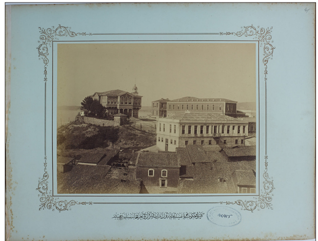
Fotoğraf 40. II. Abdülhamit Han Fotoğraf Albümlerinde yer alan postane ve telgrafhane yapılarından örnekler (Gelibolu Hükümet Konağı’yla Adliye, Jandarma Daireleri ve Telgrafhanesi) (İÜNEK, 2020, No. 90455/41) / Photograph 40. II. Examples of post office and telegraph office buildings in Abdülhamit Han Photo Albums (Gallibolu Government Office, Courthouse, Gendarmerie Offices and Telegraph Office) (IÜNEK, No. 90455/41).
