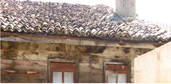
Şekil 8. Çatı dış görünüş
