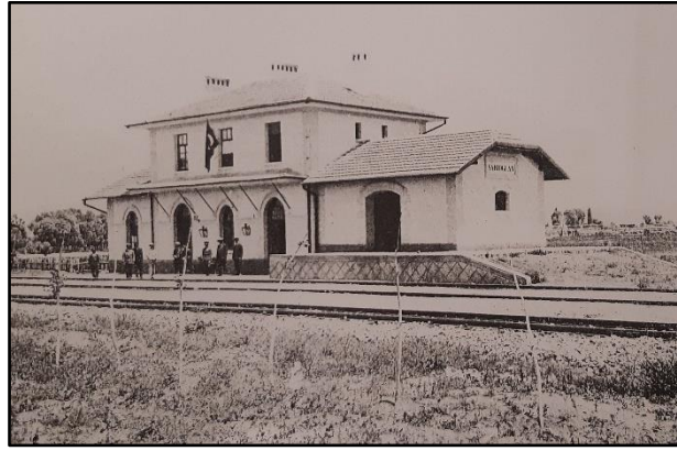
Şekil 9: Sarıoğlan İstasyon Binası. Kaynak: Devlet Demiryolları ve Limanları Umumi İdaresi, Ankara-Sivas Demiryolu Sivas İstasyonunun Resmî Küşadı Hatırası , İstanbul: Haydarpaşa-Demiryolları Matbaası: 932, 1930.
