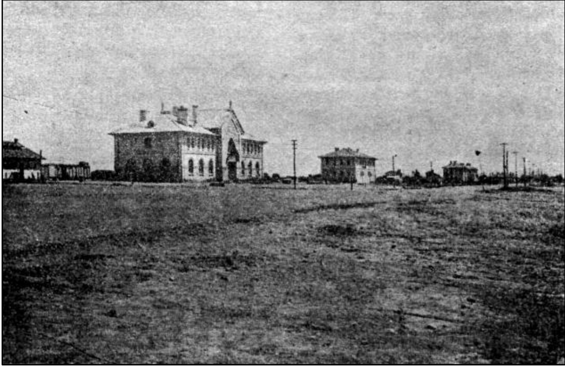
Şekil 7: Kayseri İstasyon Binası ve yakın çevresi. Kaynak: 10 Yılda Türkiye Nafiası 1923-1933 , İstanbul: T.C. Nafia Vekâleti, Matbaacılık ve Neşriyat Türk Anonim Şirketi, 1933.
