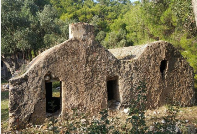
Fotoğraf 4- Yapının güney cephesi
