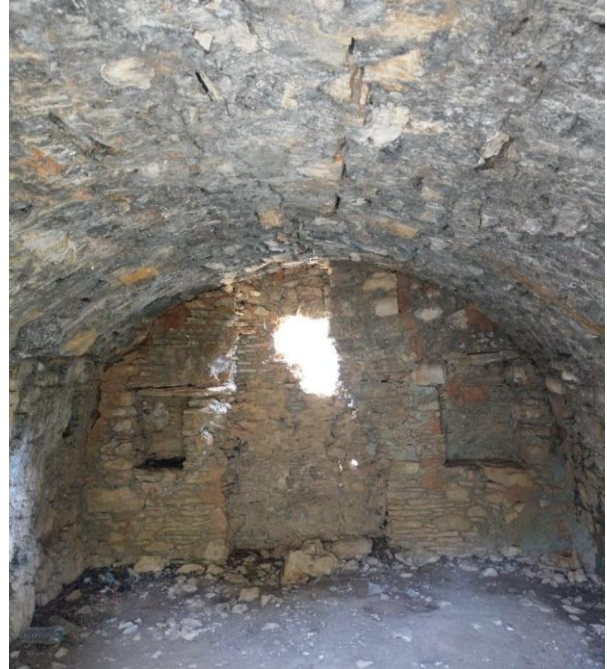
Fotoğraf 5- Doğu mekânın güney duvarı
