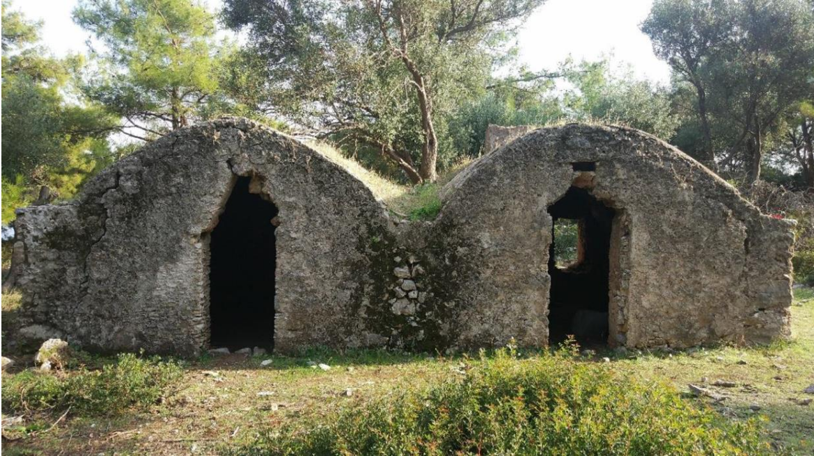
Fotoğraf 3- Yapının kuzey cephesi
