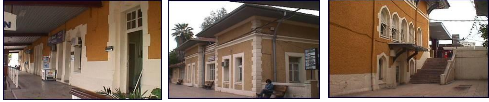
Şekil 4.19 Kuzey (Peron) Cephesi, Sağlık Müdürlüğü Binası, Perona Geçişi Dış Merdiven
