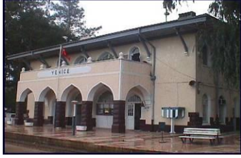
Şekil 4.25 Yenice İstasyon Binası
