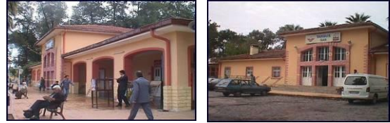
Şekil 5.3 Tarsus İstasyon Binası Şehir ve Peron Yönünden Bakış
