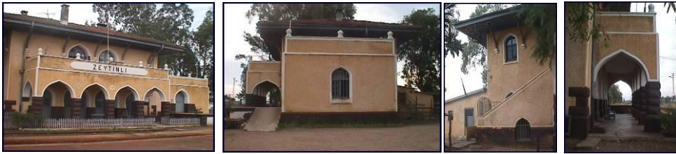
Şekil 4.24 Zeytinli İstasyon Binası Doğu Yönünden Bakış, Batı Cephesi, Dış Merdiven, Revak
