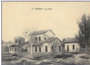
Şekil 4.11 Tarsus Eski İstasyon Binası
