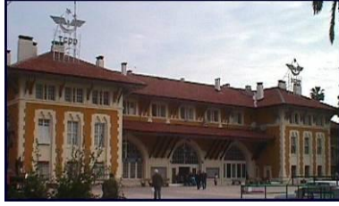
Şekil 4.15 Adana İstasyon Binası
