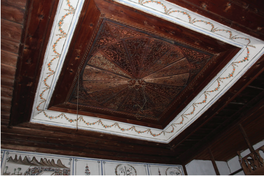
G. 4: Keles Kemaliye Köyü Camii, ahşap tavan göbeği (Algaç, 2019)
