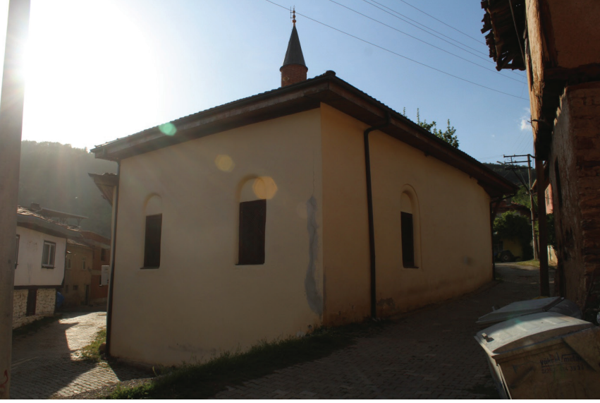
G. 3: Keles Kemaliye Köyü Camii, güney ve doğu cephesi (Algaç, 2019)
