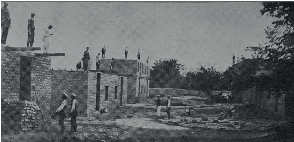
Lev. 7: Elazığ, Perçenç'te (bugün değiştirilen ismi ile Akçakiraz) inşa edilen köy evleri, 1935. / Village houses under construction in Elazığ, Perçenç (Today the name of the settlement is Akçakiraz) (Cumhurluk Devrinde Elaziz, İl ve İlçelerde Bayındırlık İşleri, 1935)
