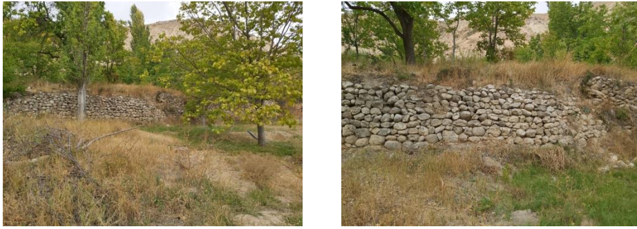
Şekil 3. Günpınar'da Surp Asdvadzadzin Kilisesi'ne ait olduğu düşünülen yapı kalıntıları (2020).
