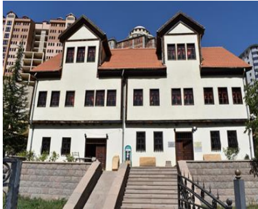
Fotoğraf 17. Gümüşhane Müzesi (İkizevler Binası) (Yazar Arşivi).
