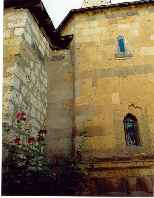
Resim 9: Elbistan Ümmet (Babaiyye–Himmet) Baba Türbesi, batı taraftan görünüş.
