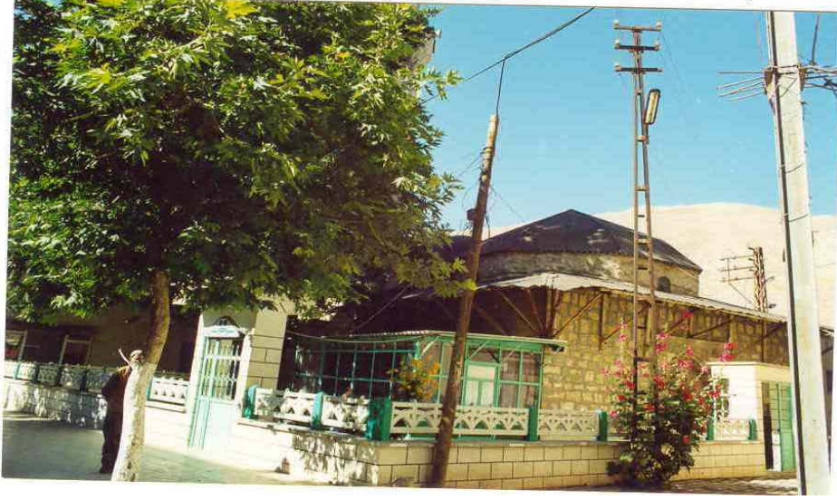
Resim 1:Elbistan Ümmet (Babaiyye-Himmet) Baba Camii, kuzeydoğu taraftan görünüş.
