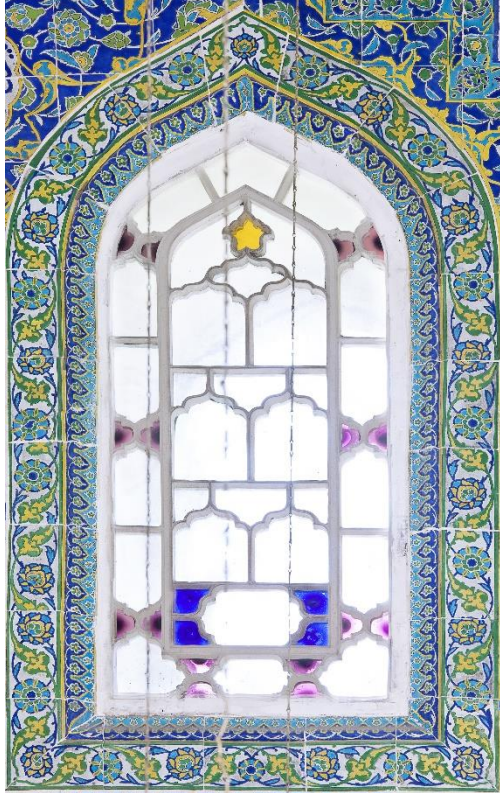
Fotoğraf 11: Doğu Duvarı Sol ve Kuzey Duvarı Sağ Pencere
