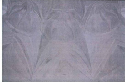
Fot.20: Mudurnu Yıldırım Hamamı erkekler kısmı sıcaklığı, büyük halvet kubbe geçişleri (Fot.VGM)
