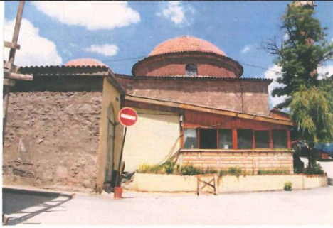
Fot.31: Bolu Orta Hamam güney cephe görünüşü
