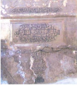
Fot.3: Mudurnu Yıldırım Hamamı erkekler kısmı taçkapısında inşa, vakfiye ve mimar kitabeleri (Fot.VGM)
