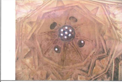
Fot.15: Mudurnu Yıldırım Hamamı erkekler kısmı sıcaklığı kubbesi (Fot.VGM)
