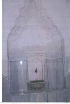
Fot.12: Mudurnu Yıldırım Hamamı erkekler kısmı ılıklik kuzey duvarında mukarnas kavsaralı niş ve kurna
