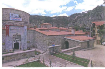
Fot.4: Mudurnu Yıldırım Hamamı kuzey cephe görünüşü (Fot.VGM)
