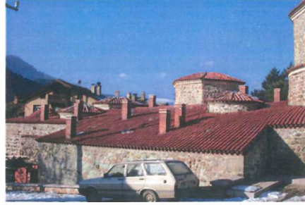
Fot.6: Mudurnu Yıldırım Hamamı güney cephe görünüşü (Fot.VGM)
