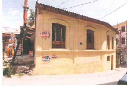
Fot.29: Bolu Orta Hamam kadınlar kısmı muhdes soyunmalığı batı cephe görünüşü
