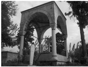
Şekil 2. Şehzade Selim Türbesi (2005)
