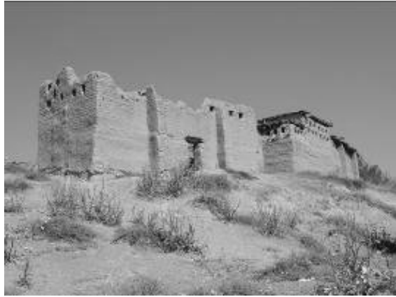
Şekil 13. Dış duvar yüzeyindeki dayanma ayakları
