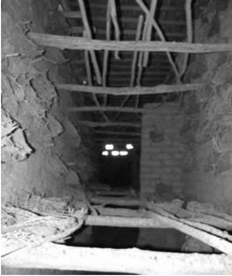
Şekil 12. İç duvarda bir dayanma ayağı
