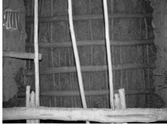
Şekil 15. Düz toprak damın alttan görünümü
